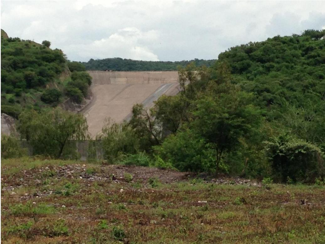
**Figura 1.8 Fotografía del vertedor de abanico en la presa. Fuente: archivo fotográfico propio.**
