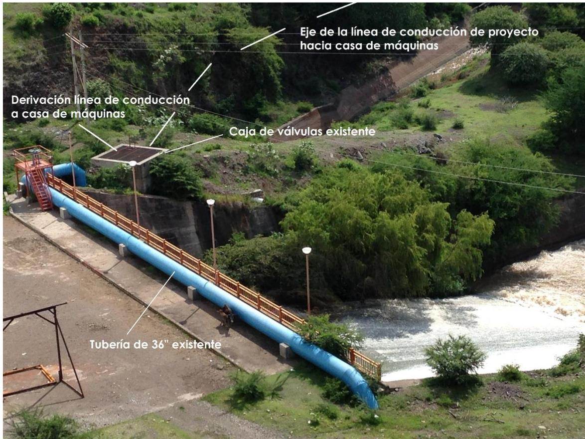
**Figura 3.3 Esquema parcial de equipamiento para la presa Andrés Figueroa. Elaboración propia.**
