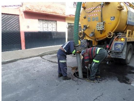
**Figura 4.2.** Extracción de sedimentos mediante camiones hidroneumáticos
