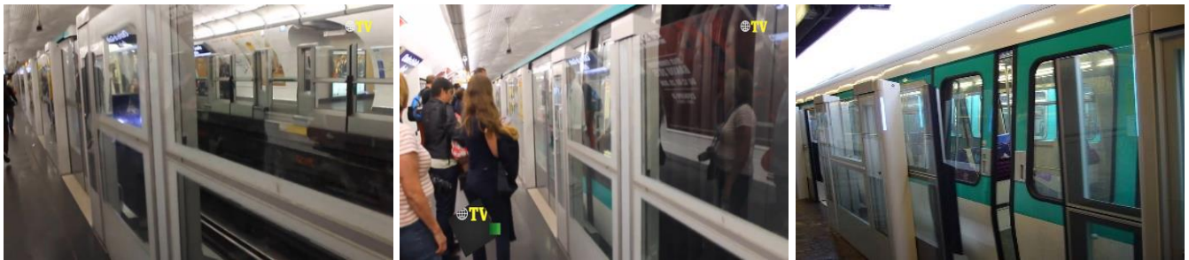
Ilustración 46. Moderno sistema en prevención de suicidios en el ferrocarril subterráneo de París. Fuente: Publmetro (2015).
