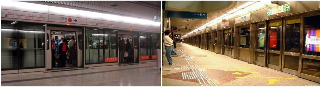
Ilustración 39. Mamparas de seguridad de cristal en el STC Metro de Singapur. Fuente: Volver Asia (2008).
