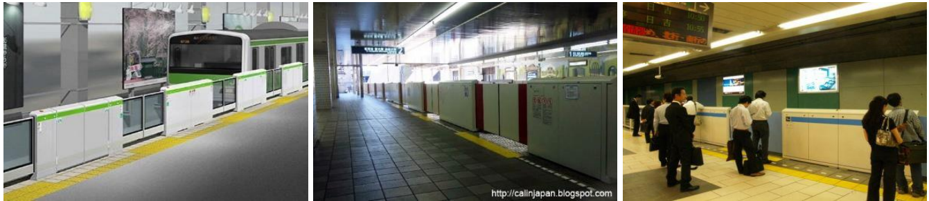
Ilustración 44. Barreras antisuicidas en el STC Metro de Tokio, Japón. Fuente: Solanas (2008).
