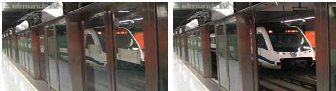
Ilustración 42. Mamparas transparentes del STC Metro de Madrid en España. Fuente: El Mundo.es Multimedia (2009).
