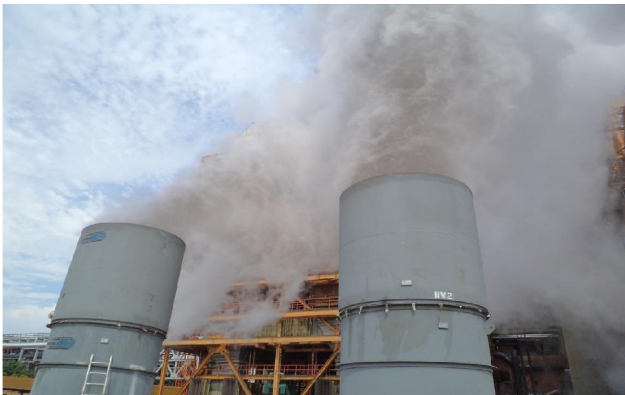
Fig. 7 Vapor sucio saliendo de los silenciadores
