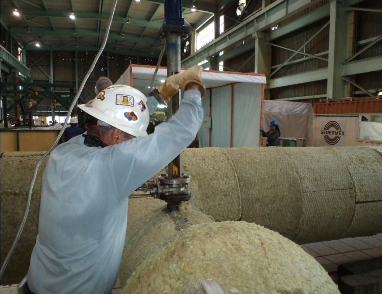
Fig. 6 Colocación de testigo para validación de limpieza en tubería de Alta Presión
