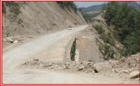
Km 0+000 E.C. Carretera Mitla – Tehuantepec II
