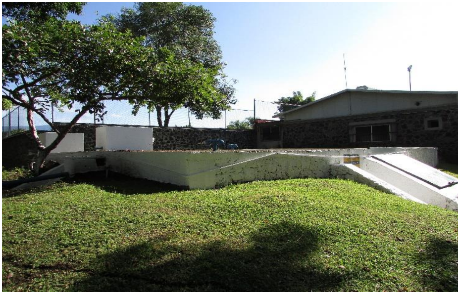
Figura 31: Depósito de regulación del IMTA.
