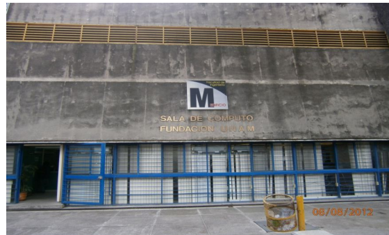
Figura 2.2: Sala de cómputo Edificio “M”
