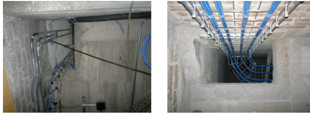
Figura 3.12: Instalación de charolas en la vertical
