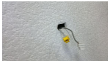
Figura 2.19: Rosetas inexistentes
