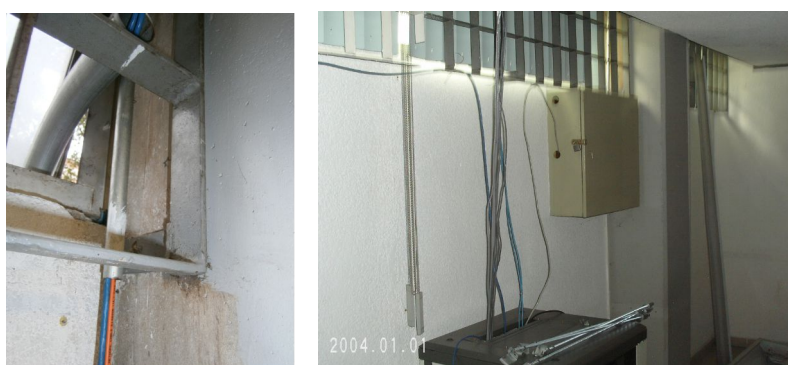
Figura 2.12: . Canalización de Fibra óptica en la vertical
