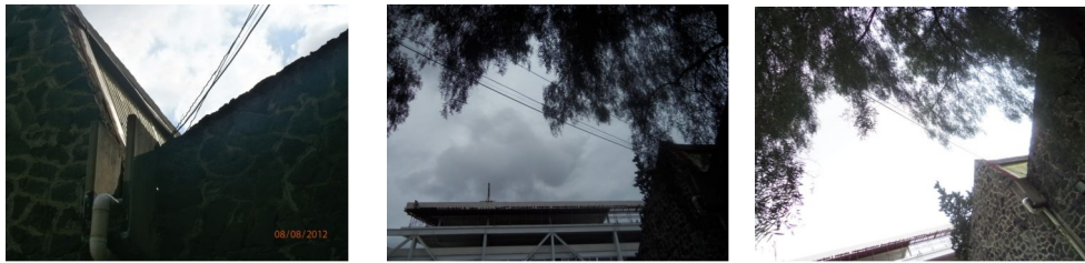
Figura 2.5: Salida de Fibra óptica del Edificio “O”.
