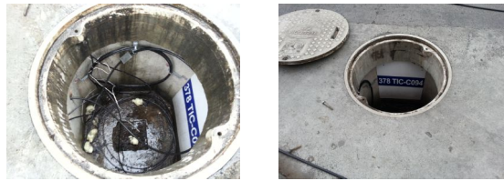
Figura 3.18: Pozos existentes de Fibra óptica creados por DGTIC, proyecto 23k.
