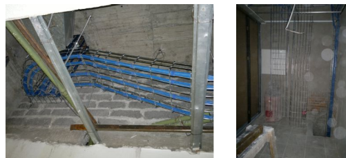
Figura 3.13: Interconexión de site por la vertical
