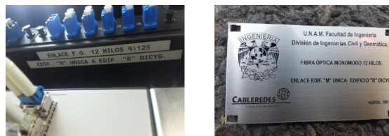
Figura 3.24: Identificación de la fibra óptica en pozos y distribuidores, en ambos extremos
