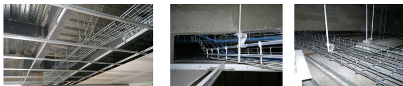
Figura 3.5: Canalizaciones horizontales
