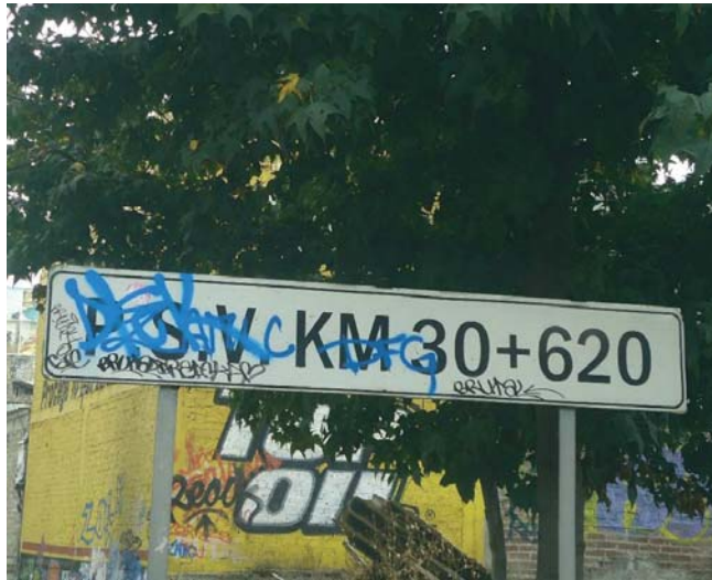
Figura 4.7 | P.S.V. KM 30+620, se encuentra vandalizado y la visibilidad del señalamiento es mala.
