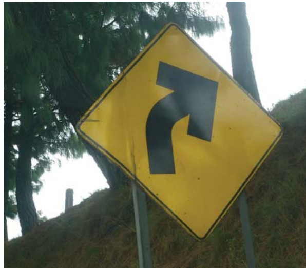
Figura 4.8 | Curva derecha, se encuentra doblado y con una fisura visible.
