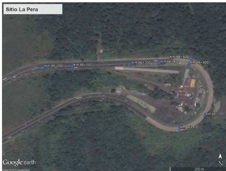
Figura 4.11 | Vista general del Sitio La Pera con los Puntos Negros (Fuente: Google Earth)
