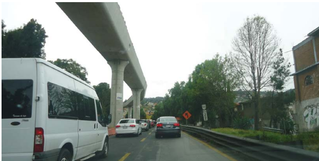
Figura 4.3 | Existencia de señalamiento vertical y horizontal con dispositivos para protección de obras ubicadas en el km 22+000.
