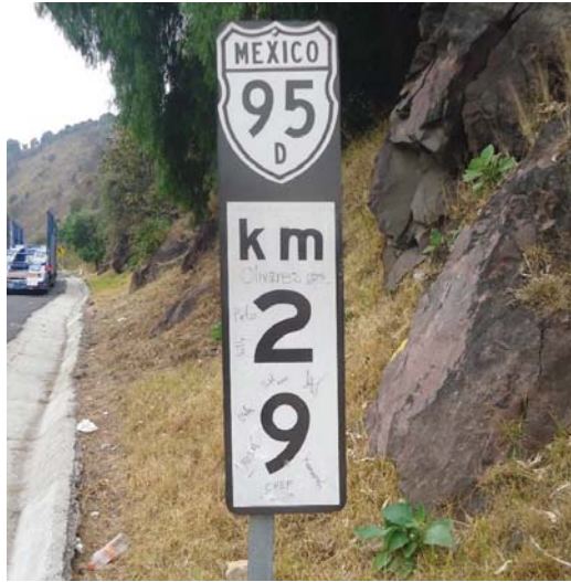
Figura 4.5 | Existencia de vandalismo con grafiti en la señal del Km 29+000, además se observa la ausencia de un tornillo en la parte de abajo.
