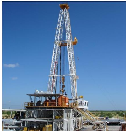
Figura 1.5 Equipo de perforación convencional.
