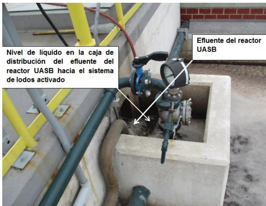
**Figura 4.1.** Salida del efluente del reactor UASB hacia al sistema de lodos activados
