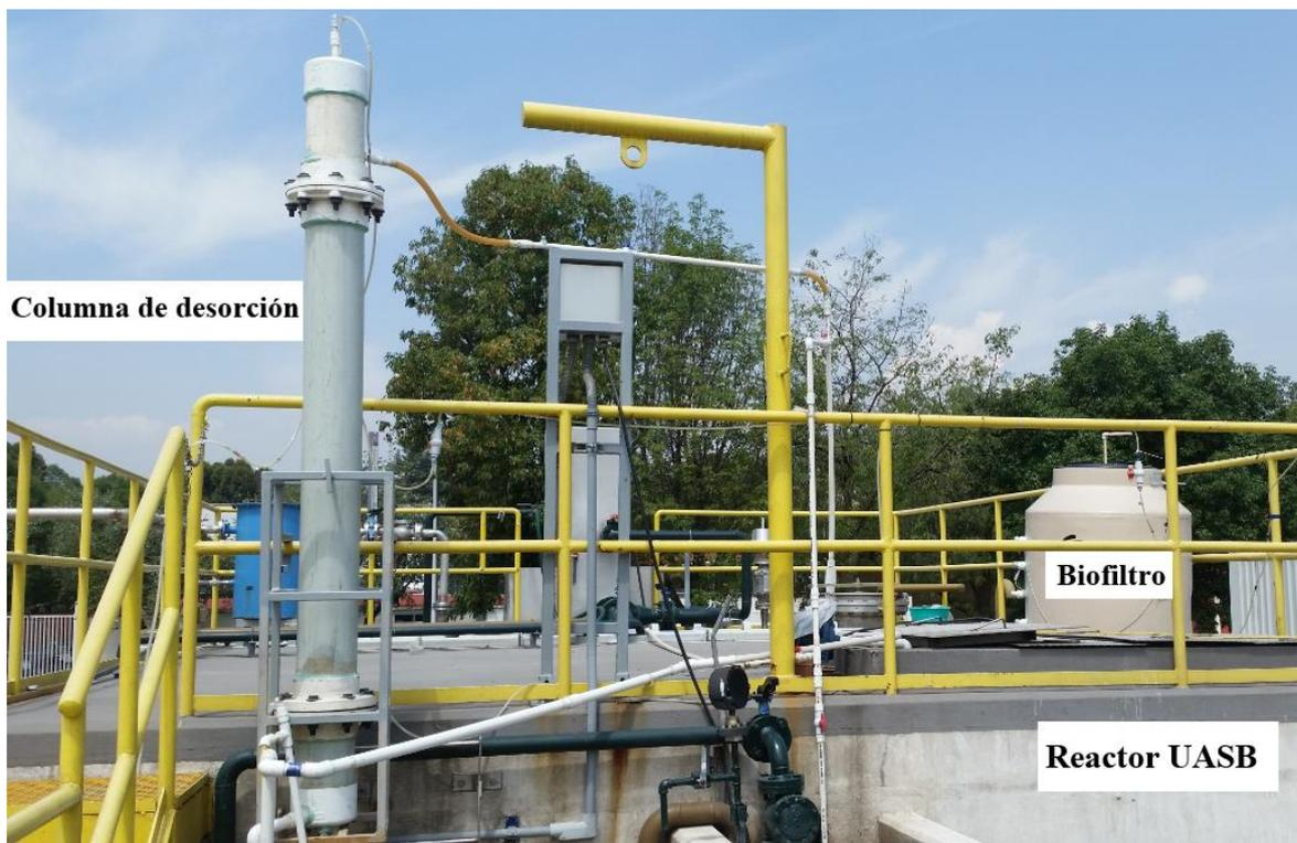
**Figura 4.3a.** Sistema para la desorción y remoción biológica de metano y sulfuro de hidrógeno disueltos en el efluente del reactor UASB
