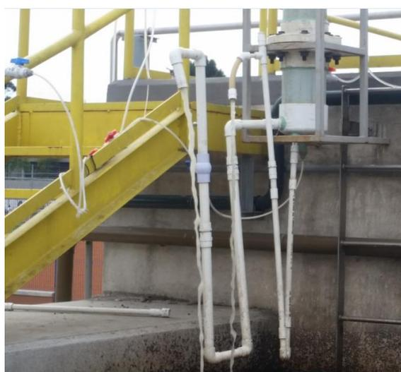
**Figura A3.3.** Salida del efluente líquido de la columna de desorción
