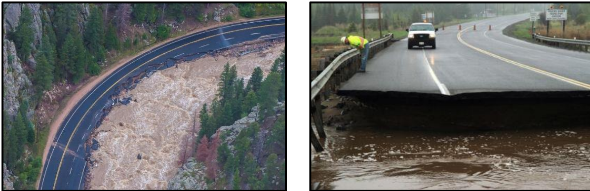
Figura 1.1. Inundación de carretera en Colorado U.S (Michler 2013)
