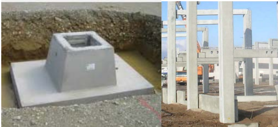
Figura 4.1 Columnas y zapatas prefabricadas
