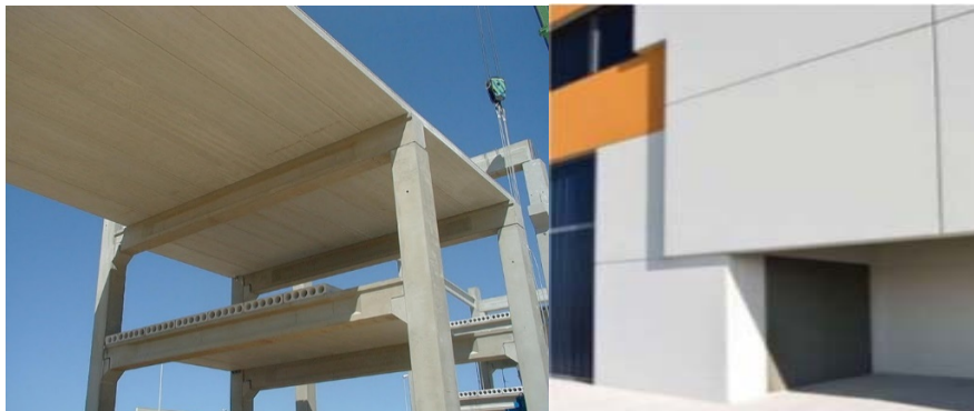
Figura 4.3 Sistemas prefabricados de piso y de fachada
