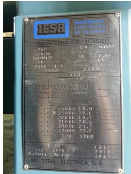
Figura 3. 5 Subestación#2 “RESIDENCIA”, capacidad de 750 KVA, 23000 – 220Y/127V, marca IESA, transformador que alimenta el edificio donde se alojan alumnos de intercambio.
