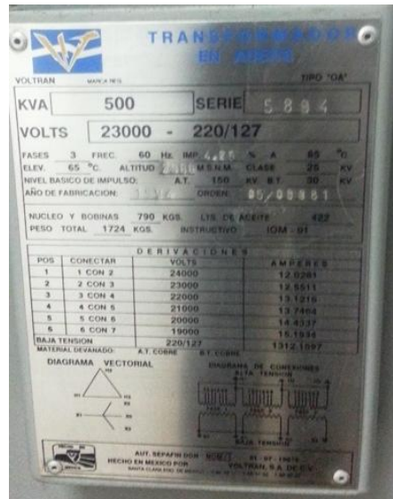
Figura 3. 4 Subestación #1 “AMERICA”, capacidad de 500 KVA, 23kV – 220Y/127V, marca VOLTRAN, transformador que alimenta el edificio América
