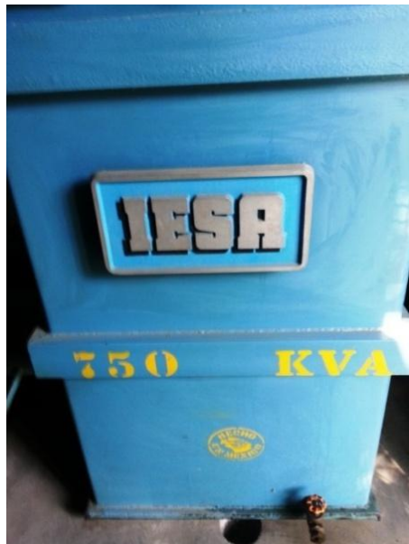
Figura 3. 5 Subestación#2 “RESIDENCIA”, capacidad de 750 KVA, 23000 – 220Y/127V, marca IESA, transformador que alimenta el edificio donde se alojan alumnos de intercambio.
