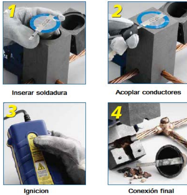
Ilustración 12 Instructivo de soldadura exotérmica marca CadWeld
