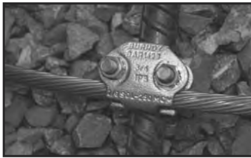
Cable con barra de refuerzo
