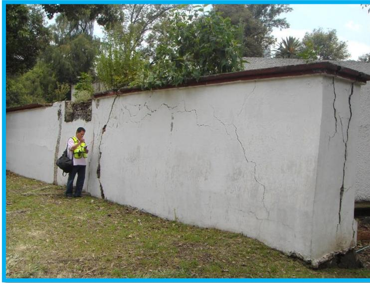
Fotografía 1. Muro dañado debido a asentamientos diferenciales del subsuelo (levantamiento de rasgos y anomalías superficiales. Facultad de Ingeniería UNAM-CONACYT, 2014).
