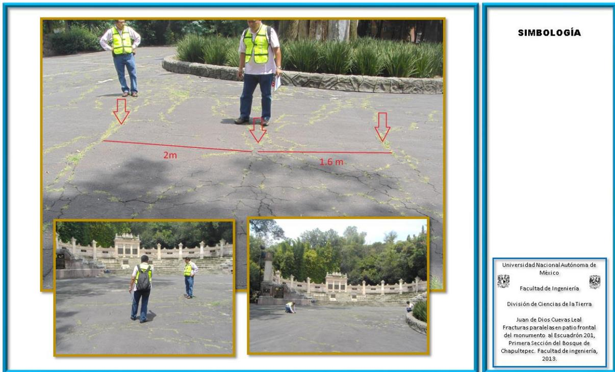
Fotografía 4. Fracturas paralelas en patio frontal del monumento al Escuadrón 201, Primera Sección del Bosque de Chapultepec (Facultad de Ingeniería UNAM, 2013).
