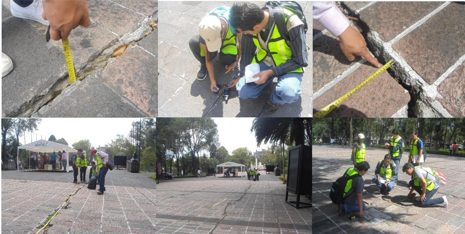
Descripción de imágenes: Levantamiento de fracturas en la Avenida Juventud Heroica, Primera sección del Bosque de Chapultepec. Facultad de Ingeniería UNAM-CONACyT, febrero 2014. En las imágenes se presenta una fractura causante de un daño al paso peatonal (adoquín), sobre el camino de acceso al Bosque de Chapultepec. La fractura presenta una profundidad de 5 cm, una abertura mínima de 1 cm y máxima de 10 cm y una longitud de más de 25m.
