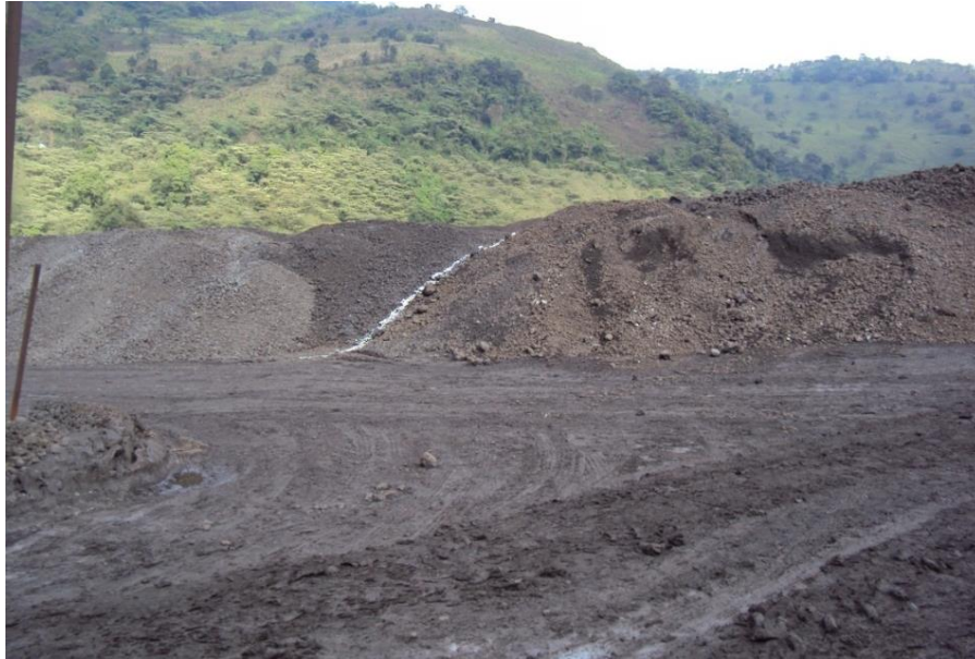
Figura 5.15.- Fotografía del Lote 724 en el terreno
