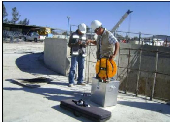
**FOTOGRAFIA 04.** Monitoreo de Inclínómetro en Muro Milán.
