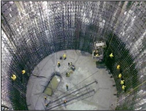
**FOTOGRAFIA 30.** Habilitado y armado de acero de refuerzo para la losa de fondo y el revestimiento definitivo de la Lumbraera.
