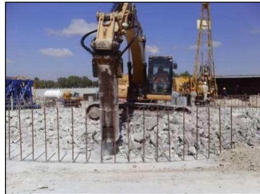
**FOTOGRAFIA 21.** Demolición de núcleo interior: se da inicio a la excavación de núcleo de la Lumbrera; al fondo de la imagen se observa el equipo de perforación para la instalación de un inclinómetro dentro del Muro Milán.
