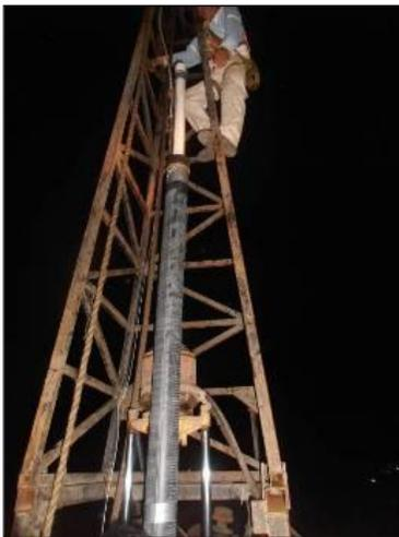
**FOTOGRAFIA 06.** Colocación de cámara piezométrica extendida.
