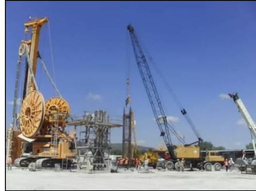
**FOTOGRAFIA 19.** Durante la construcción del Muro Milán se realizaron trabajos simultáneos: perforación con equipo guiado y colocación de acero de refuerzo de los paneles y colocación de concreto con tubería tremie.
