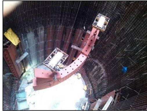
**FOTOGRAFIA 31.** Maniobras de descenso de la estructura metálica para el emportalamiento de la entrada del túnel.
