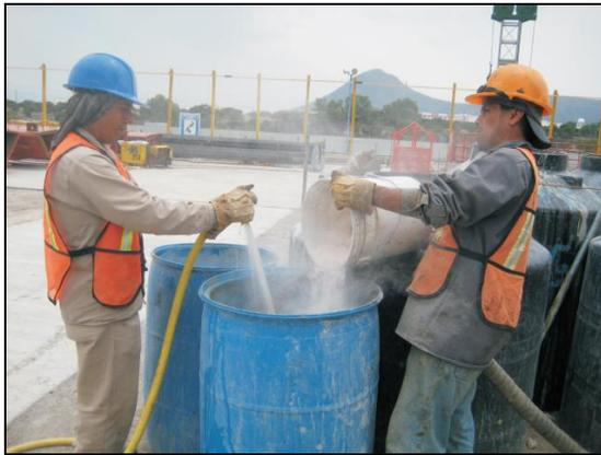
**FOTOGRAFIA 10.** Trabajos de preparación de mezcla agua-cemento-bentonita para la inyección en el espacio anular de la tubería guía y el barreno.
