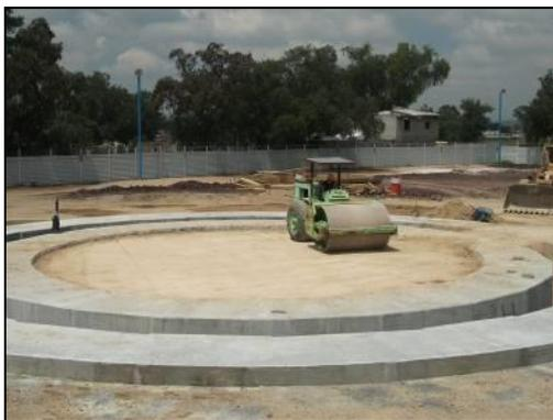
**FOTOGRAFIA 16.** Construcción de brocal exterior, mejoramiento del suelo del brocal interior para evitar asentamientos del suelo producidos por el peso de la excavadora “Hidrofresa”; con ello se pretende garantizar la verticalidad de los tableros.
