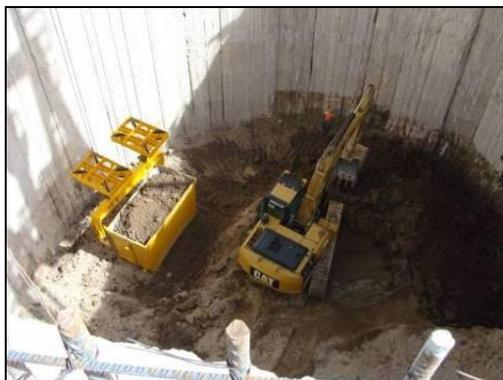
**FOTOGRAFIA 22.** Excavación del núcleo de la Lumbrera y limpieza de los tableros del Muro Milán.
