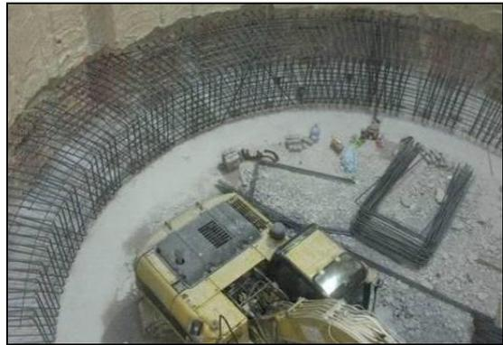
**FOTOGRAFIA 25.** Escarificado de tableros previo al habilitado y armado de acero de refuerzo para la trabe de liga.
