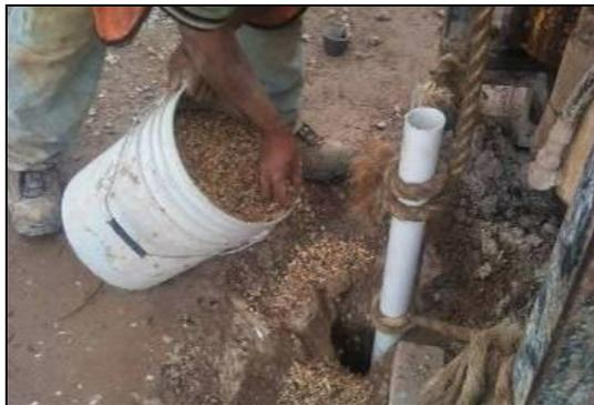
**FOTOGRAFIA 14.** Colocación de filtro de arena sílica.
