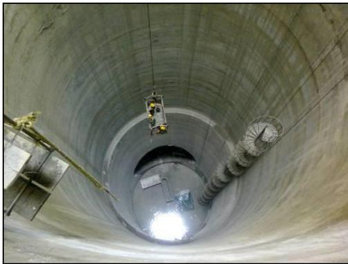
**FOTOGRAFIA 35.** Panorama general de la Lumbra al término de su construcción; en la figura se aprecia la colocación de instalaciones auxiliares.
