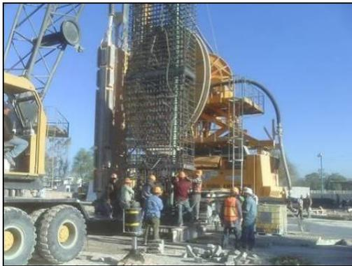
**FOTOGRAFIA 20.** Colocación de acero de refuerzo para el Muro Milán dentro de la perforación
