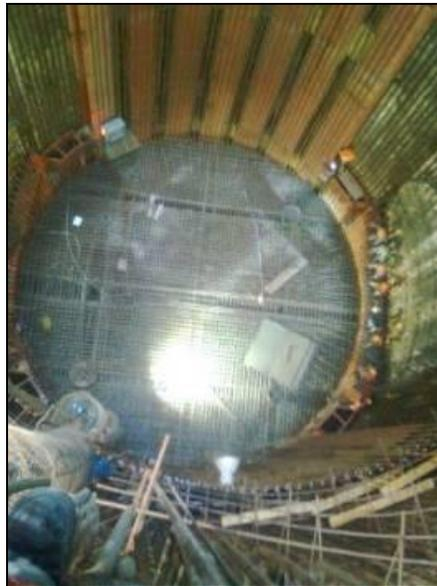
**FOTOGRAFIA 32.** Panorama de la Lumbraera L-20 al término del armado de acero de refuerzo de losa de fondo, colocación de estructura de emportalamiento en la entrada de túnel, revestimiento con acero de refuerzo en las paredes de la Lumbraera.
