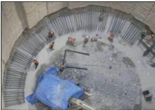
**FOTOGRAFIA 26.** Construcción de la trabe de liga; unión estructural del Muro Milán con método Convencional.
