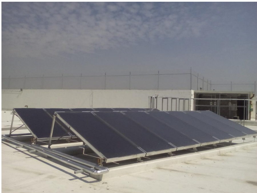
Imagen 1. Colectores solares planos de serpentín
