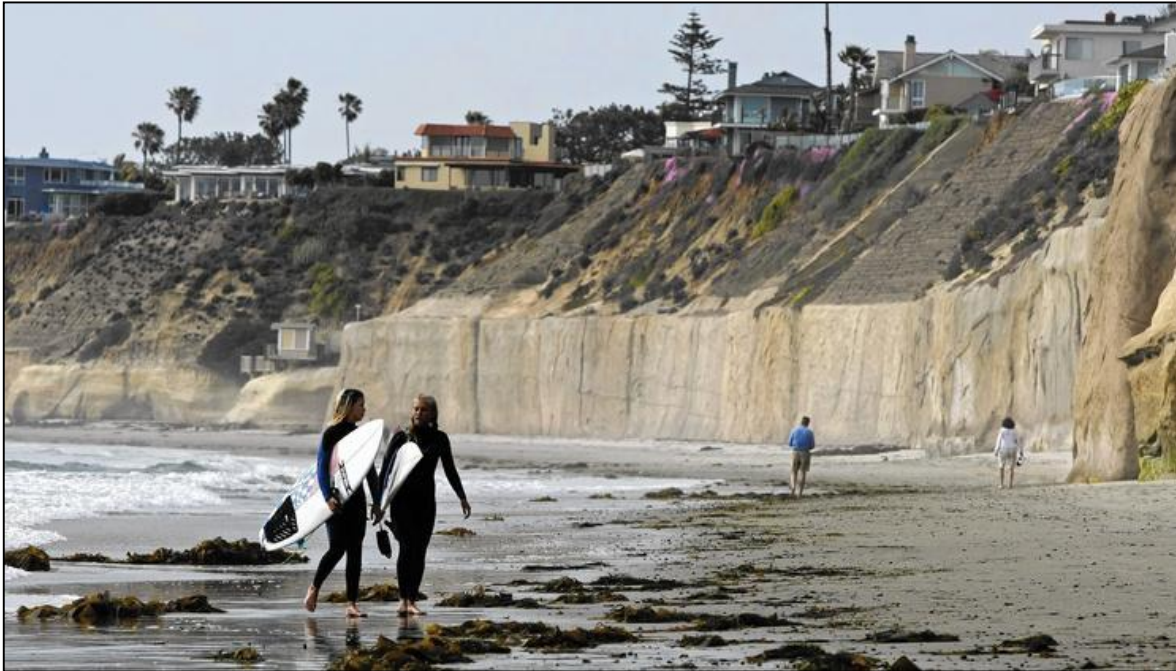
Figura 2-1 Muros de contención alineados a los acantilados en Solana Beach, California, EUA (Don Bartletti/Los Angeles Times, 2016).
