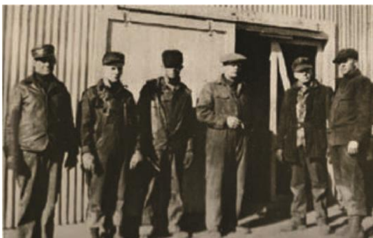
Fig. 2.4 Instalación ESP # 1. Contrato de arrendamiento petrolero Phillips, cerca de Burns, Kansas, 1928. Cortesía de ESP pump.com.
