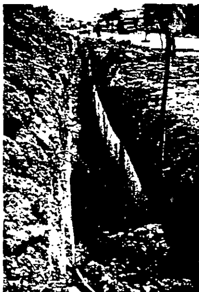
Subdrén geocompuesto prefabricado colocado en la zanja.
