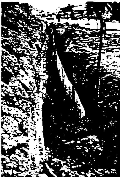
Este sistema, a diferencia del subdrenaje tradicional no requiere de tubería perforada, material de filtro ni de plantilla de arena, sino, que la zanja se rellena con el material producto de la excavación, la que se realiza con una máquina zanjeadora que puede tener anchos de cepa tan reducidos como de 30 a 50 cm, minimizando el volumen de excavación que requiere el sistema convencional. Lo anterior se traduce en importantes ahorros de tiempo y recursos, sin menoscabo en la calidad.
