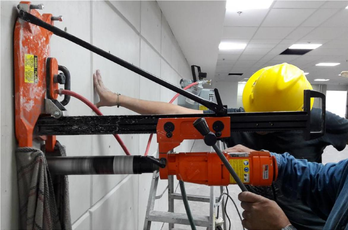
*Figura 14: Extractora en operación.*
