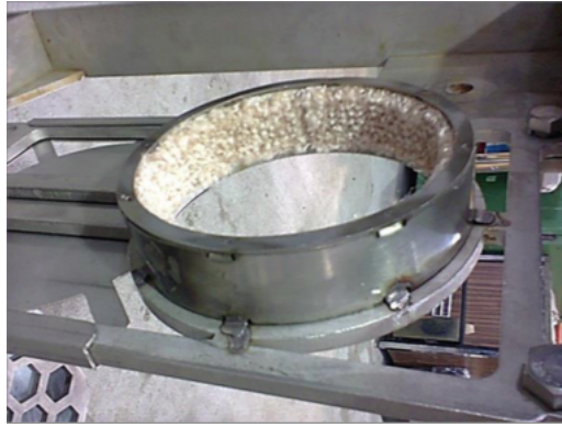
Figura 7.5: Guarda felpa punteada al marco de la guillotina.
