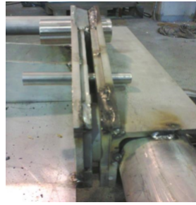
(d) Detalle de la soldadura.
