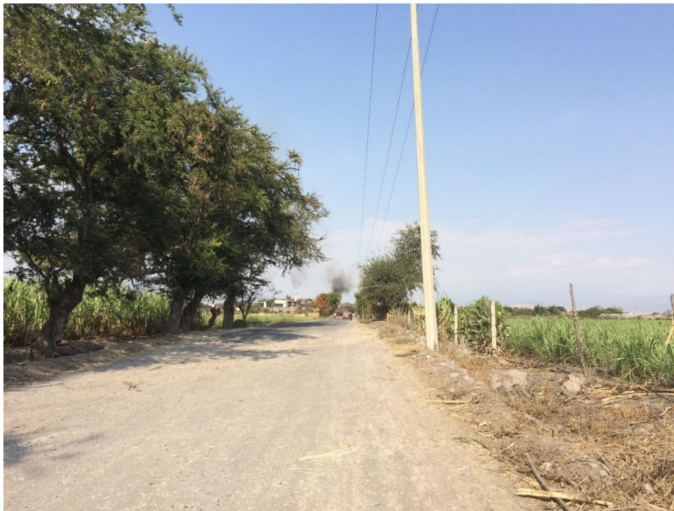
Ilustración 18. Inicio del camino km 0+000, unión con camino de conexión al Ingenio y CONAPLOR.
