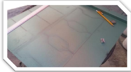
Fig. 5.7.- Trazo de las figuras geométricas en placa de hierro de 1.2mm de espesor, que servirá para apisonar el concreto.
