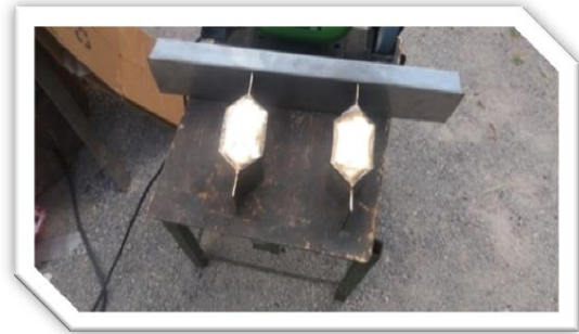
Fig. 5.3.- Presentación de las piezas intermedias del molde para verificar medidas antes de aplicar soldadura.
