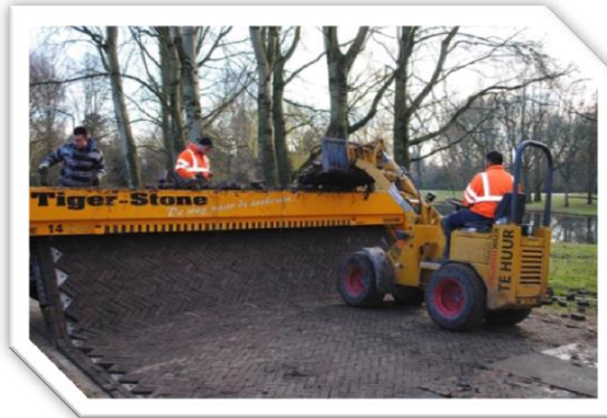
Fig. 1.5.- Colocación de adoquines con pavimentadora. [33]
