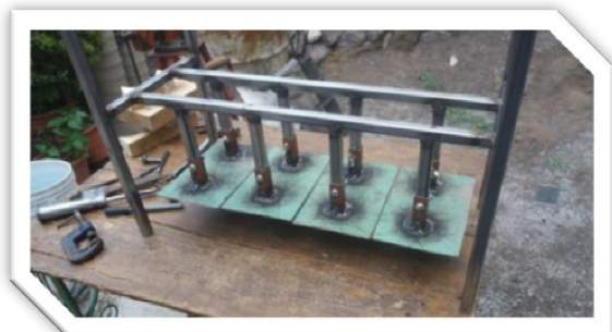
Fig. 5.8.- Colocación de las extensiones que servirán para ajustar el espesor de los adoquines con sus respectivas placas.
