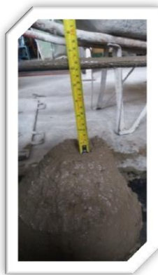
Fig. 5.20.- Verificación del revenimiento de la mezcla.
