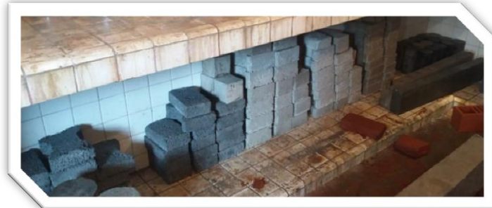
Fig. 5.45.- Después de elaborados los adoquines se ingresan a la cámara de curado para que posteriormente se puedan realizar los ensayos programados.
