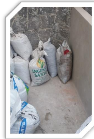
Fig. 3.3.- Nicho para el almacenaje de materiales.
