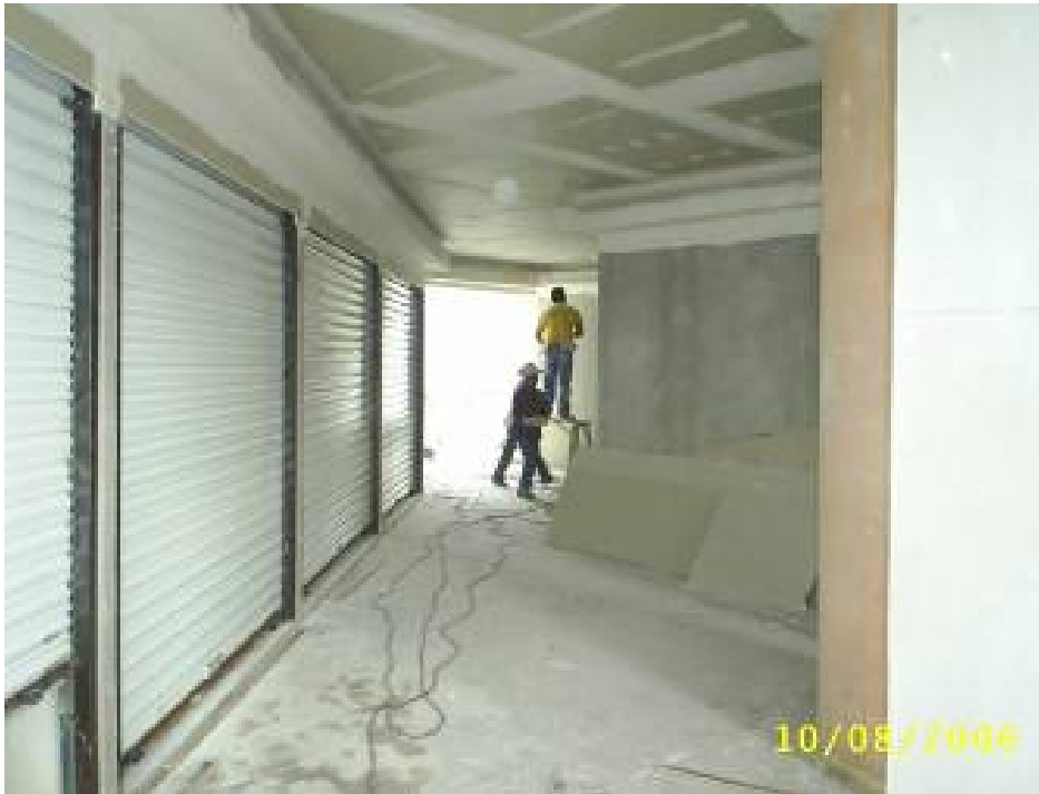
Fotografía II.29.- Instalación de cortina metálicas en cada uno de los locales comerciales
