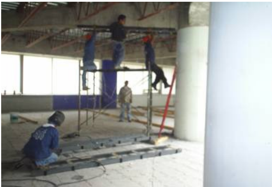
Fotografía II.21.- Reparación de trabes con colado de baja calidad.
