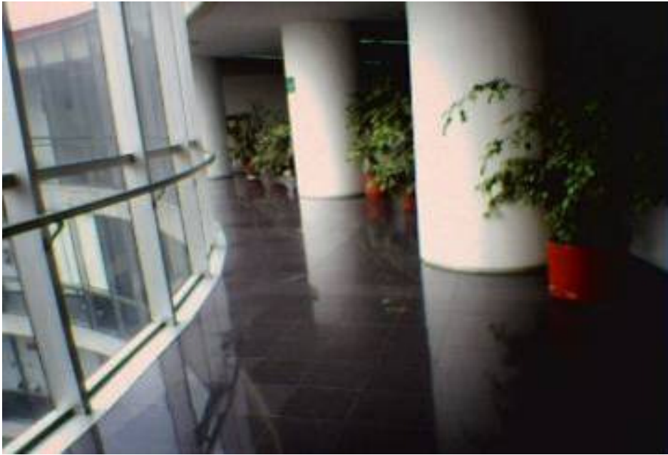
Fotografía II.4.- Columnas de sección circular de 1.2 m de diámetro para todos los niveles.
