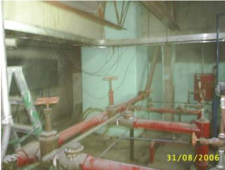
Fotografía II.27.- Mantenimiento de las instalaciones hidrosanitarias (sótano)
