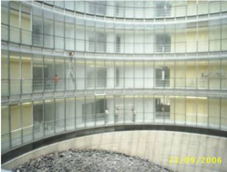
Fotografía II.20.- Retiro de Cristales del cancel para permitir ventilación
