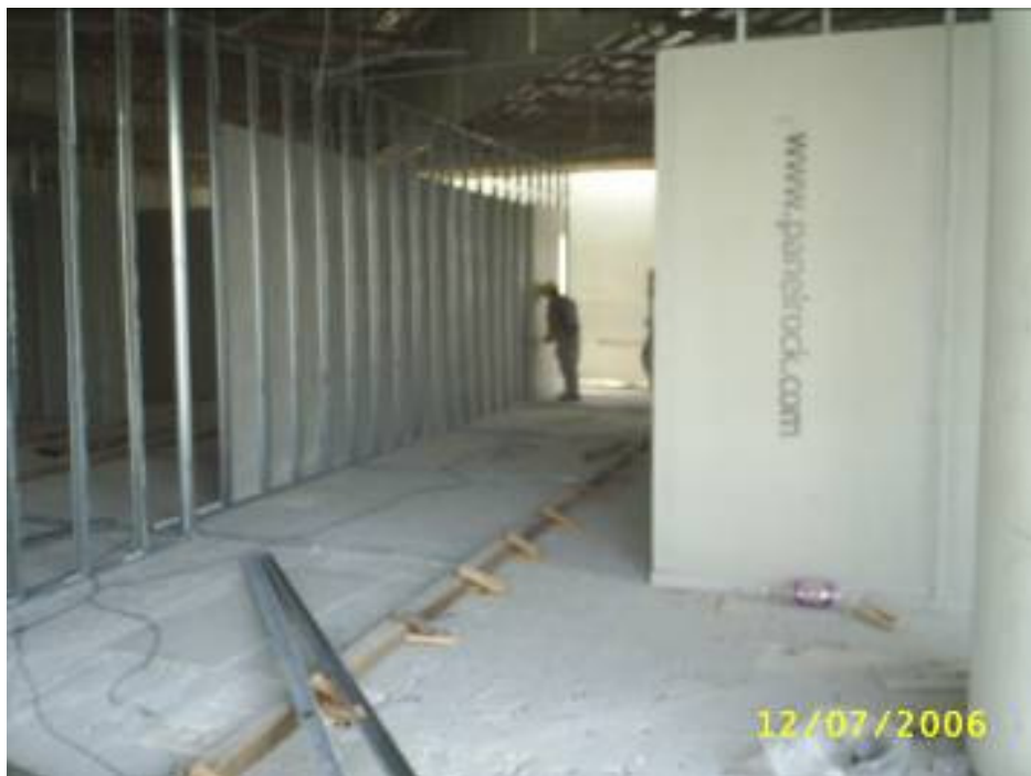
Fotografía II.24.- Inicio de la construcción de locales comerciales con tabla-cemento.
