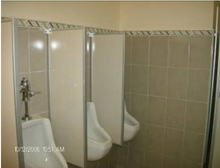
Fotografía II.14.- Sanitario Hombres (tipo)
