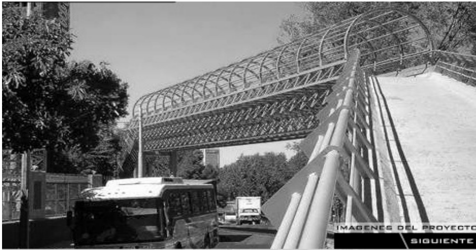
c.- Puente Peatonal
