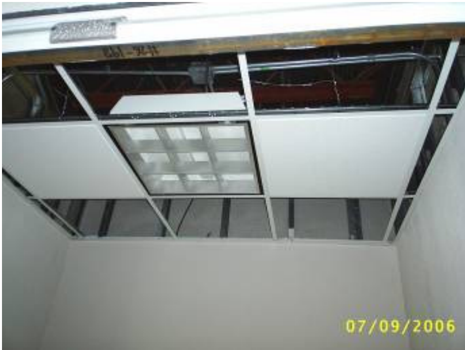
Fotografía II.30.- Instalación de plafón, lámpara al interior de los locales comerciales
