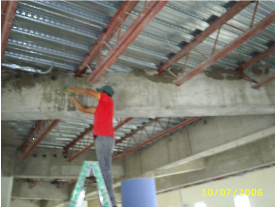
Fotografía II.33.- Resane con mortero
