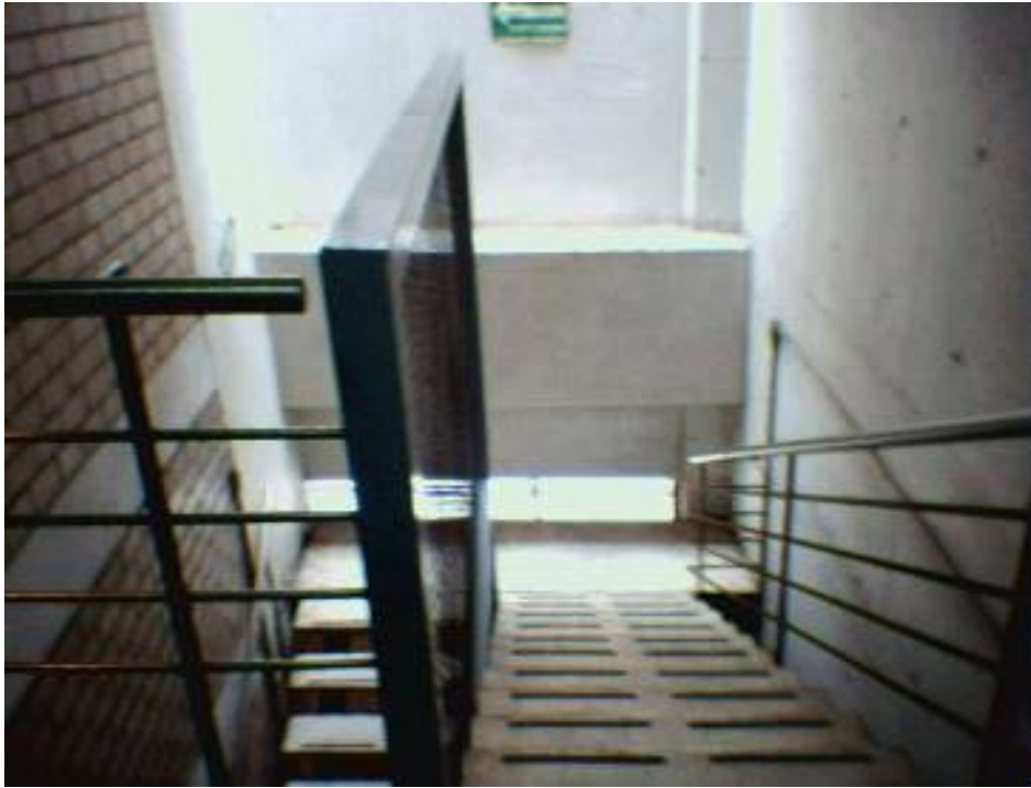
Fotografía II.9.- Escalera Norte (escalera de emergencia).
