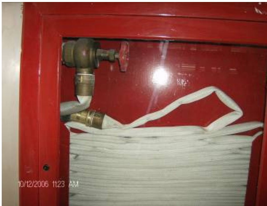
Fotografía II.31.- Revisión y sustitución de las mangueras en los sistemas de hidrantes.
