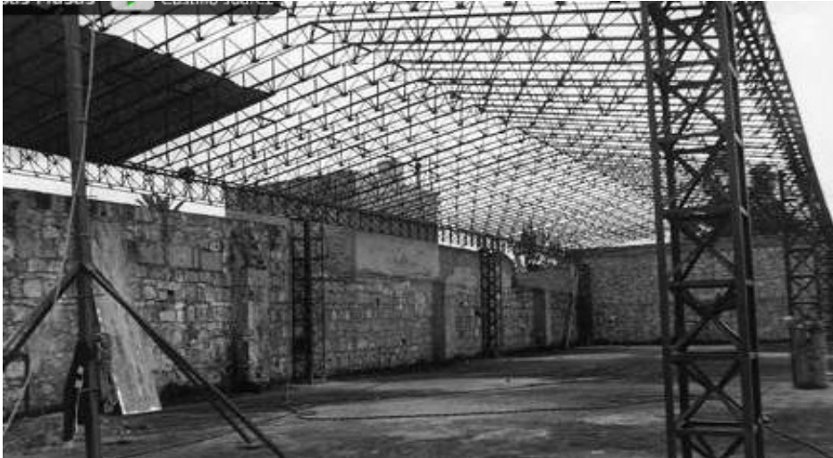
f.- Nave Industrial
