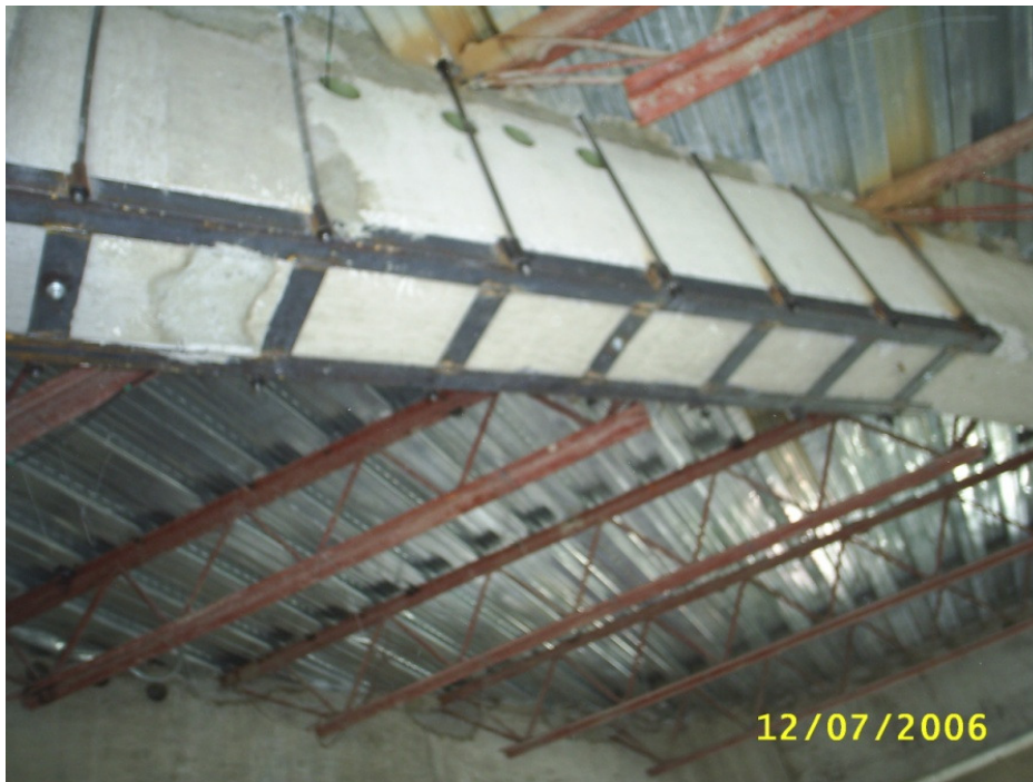
Fotografía II.34.- Reforzamiento con encamisamiento metálico de traveses de concreto.
