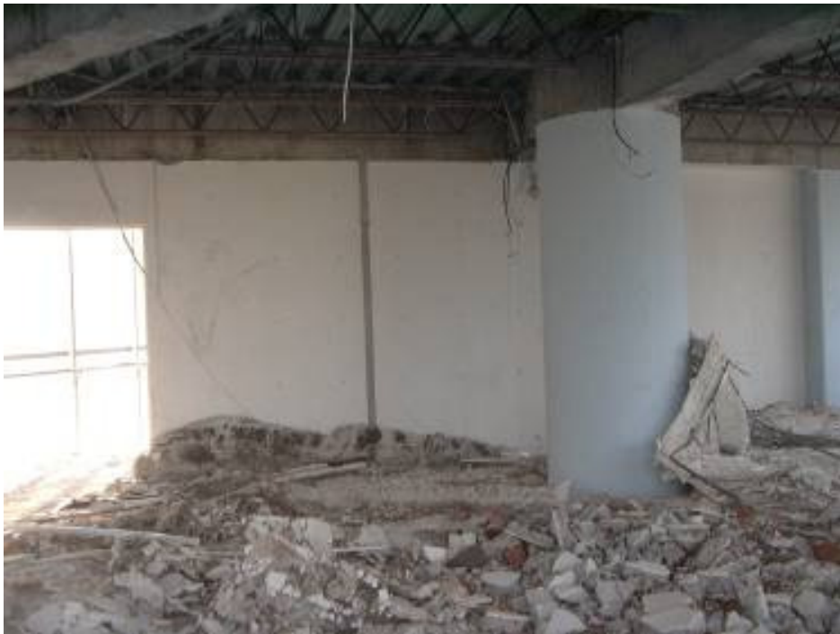
Fotografía II.17.- Producto de demolición
