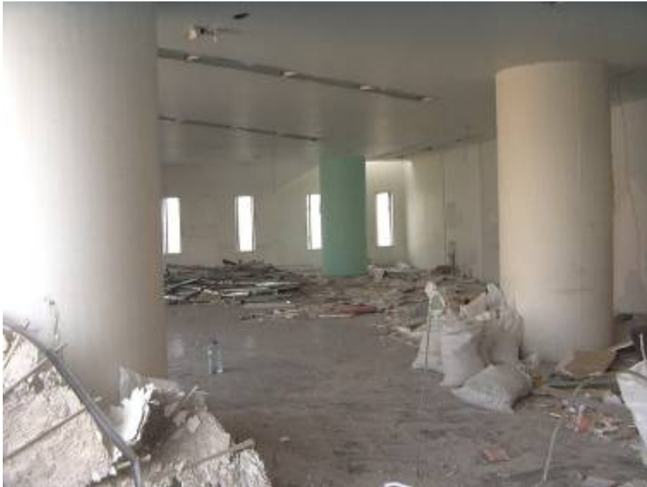
Fotografía II.18.- Demolición y desmantelamiento
