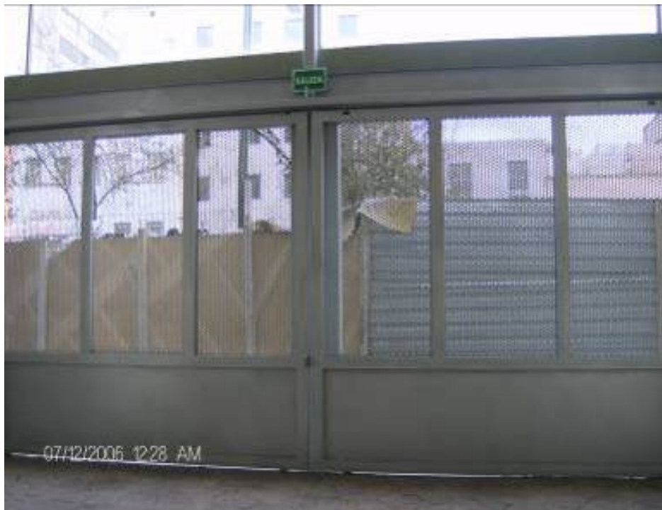
Fotografía II.16.- Portón de entrada a la plaza sobre el eje central
