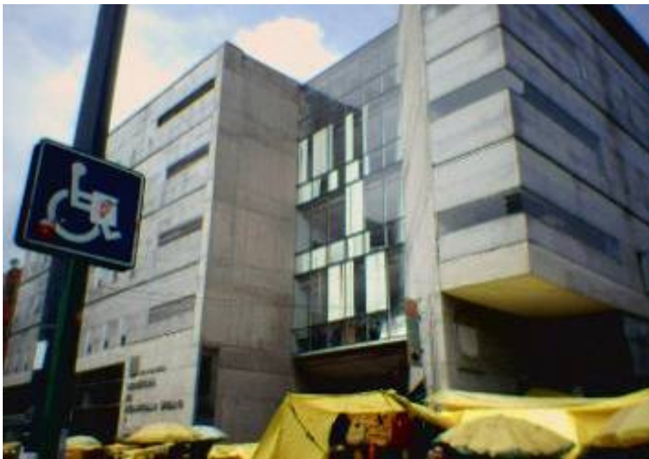
Fotografía II.2.- Edificio Victoria No. 7. Fachada Sur.
