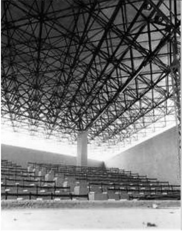
e.- Domo y Cubierta
