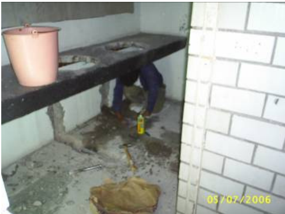
Fotografía II.23.- Trabajos de trazo y albañería en sanitarios
