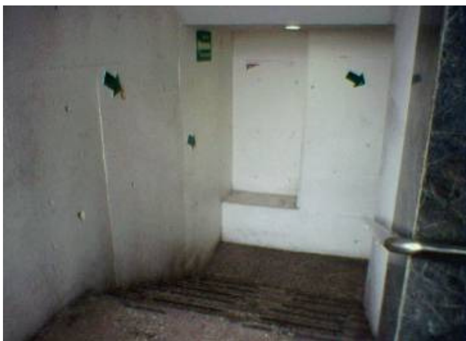
Fotografía II.8.- Escalera sur que desarrolla alrededor del cubo de elevadores
