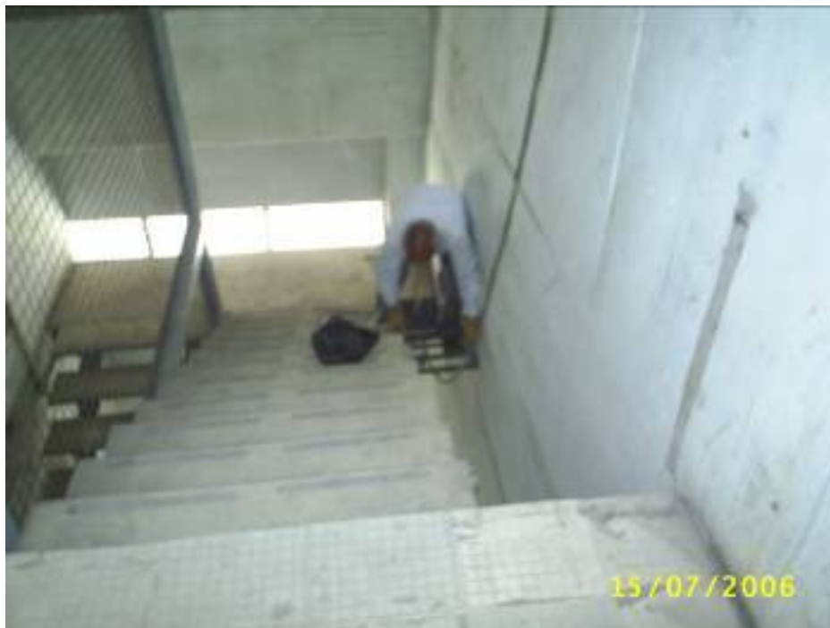
Fotografía II.26.- Mantenimiento de la escalera de emergencia (escalera norte)
