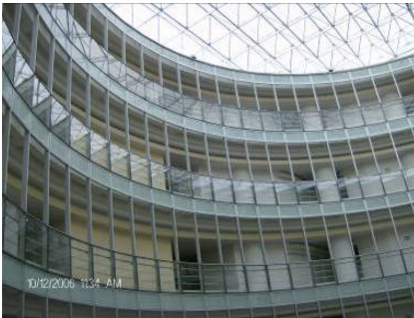
Fotografía II.12.- Espacio cilíndrico central cubierto con tridilosa
