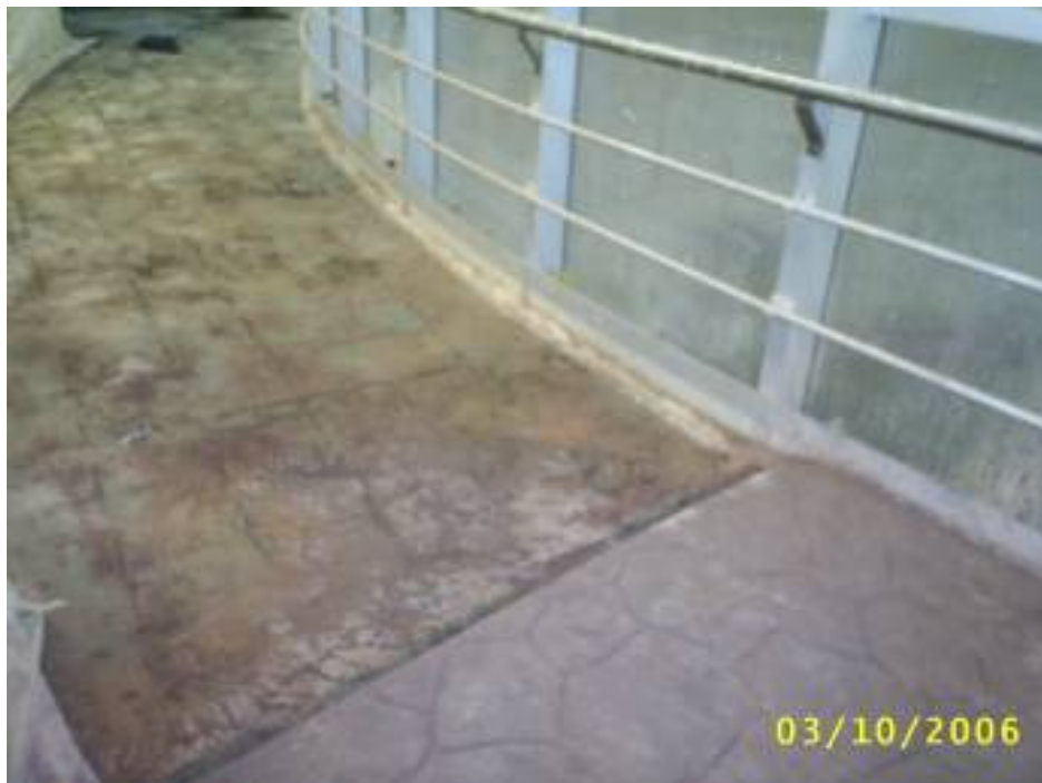
Fotografía II.25.- Fraguado del concreto estampado en áreas de circulación
