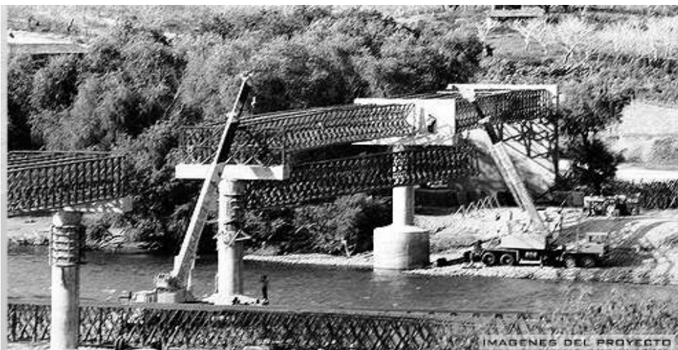
b.- Puente Vehicular
