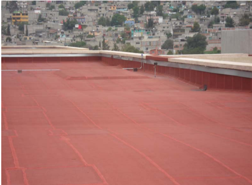
Foto 54 Terminado de impermeabilización
