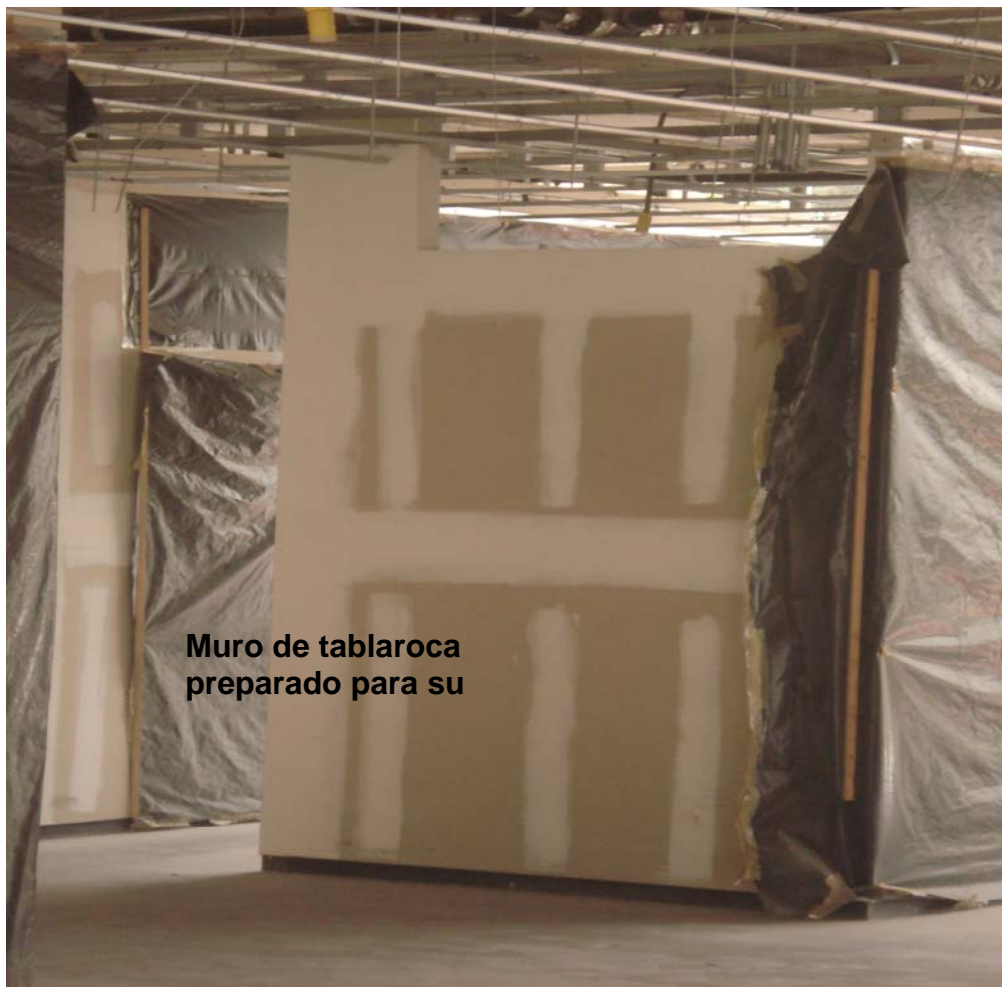
Foto 50 Muro de tablaroca terminado para acabado final
