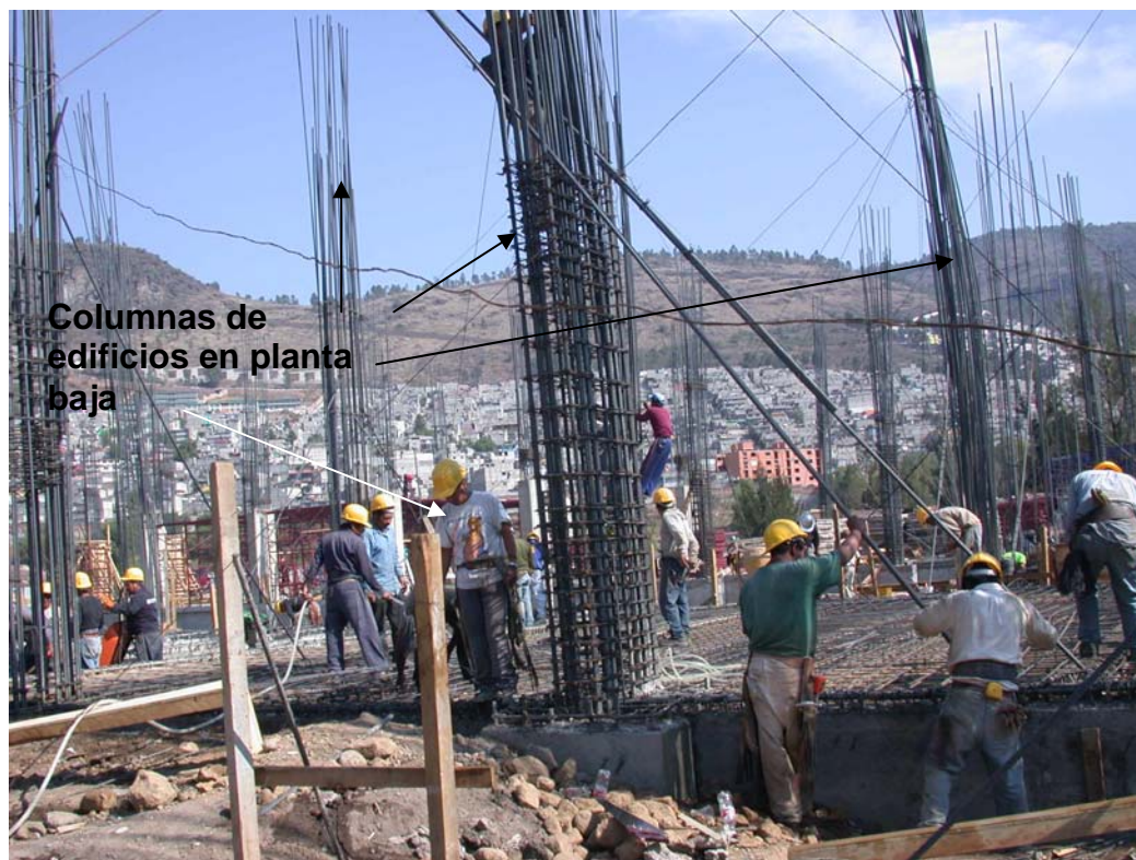
Foto 28 Colocación de acero de refuerzo en columnas de planta baja de edificio en estudio
