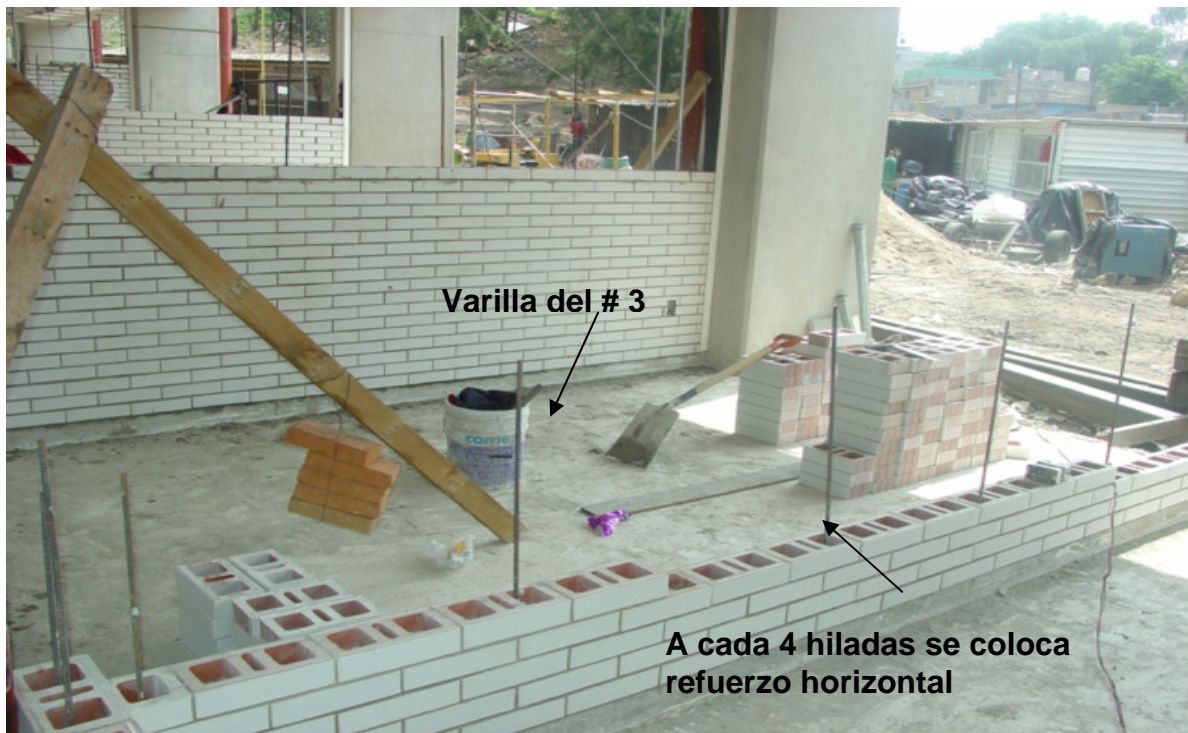
Foto 40 Muro de block Santa Julia (preparación para refuerzo horizontal)
