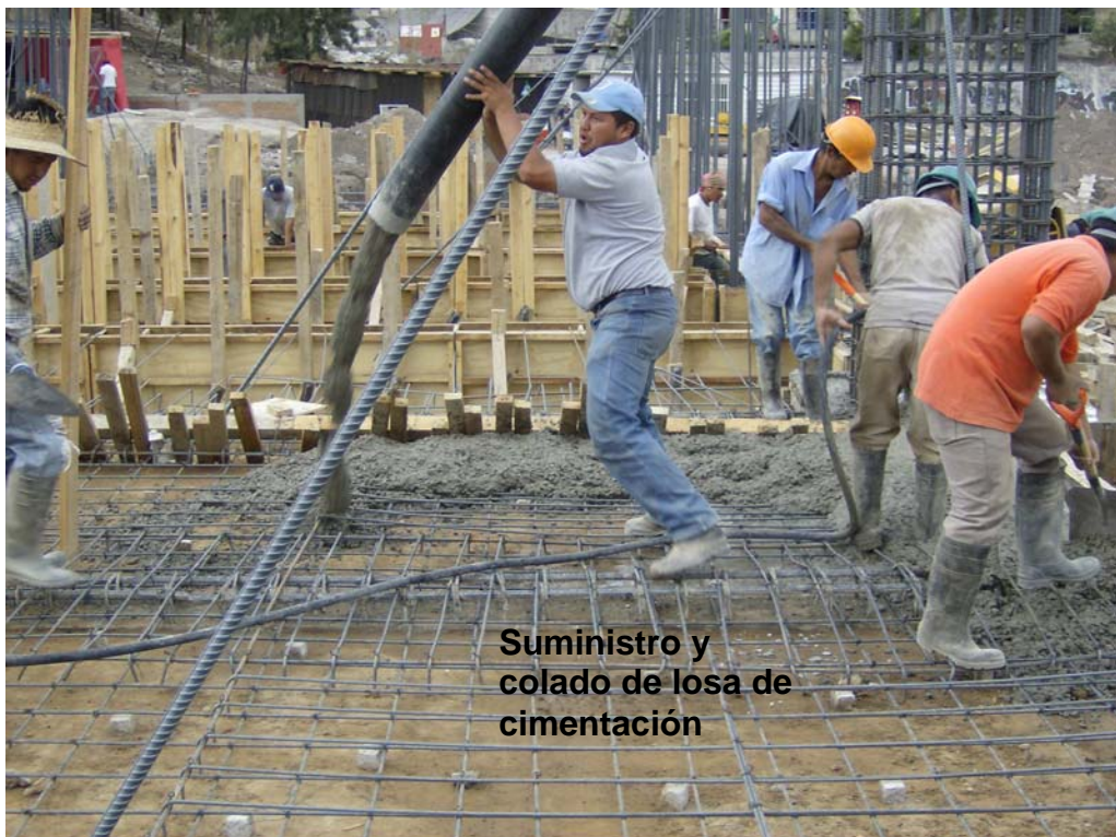
Foto 26 Colado con bomba de la losa de cimentación
