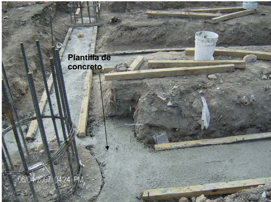
Foto 17 Suministro y colocado de plantilla de concreto
