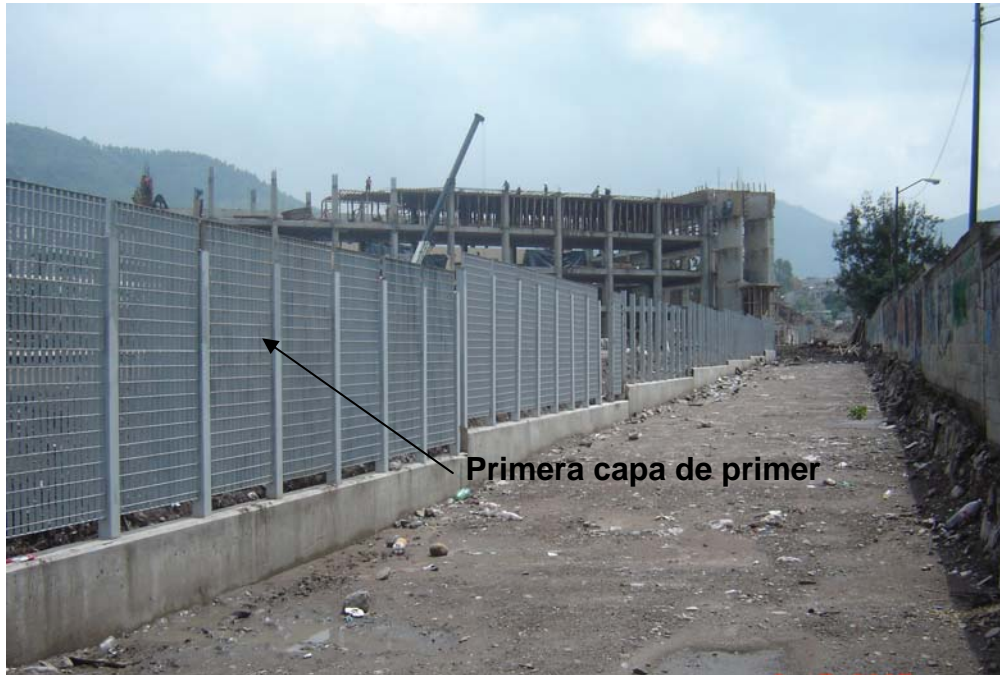
Foto 6 Aplicación de primera capa de primer
