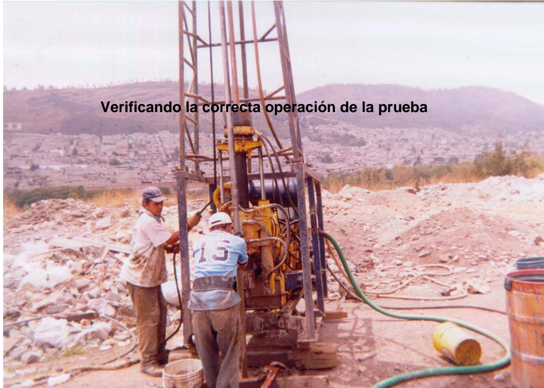
Foto 5 Ejecución de la cuarta prueba de penetración estándar
