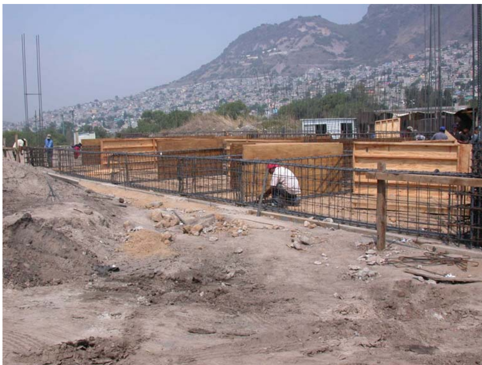
Foto 19 Armado de acero y cimbra para contratrabes y dados de cimentación
