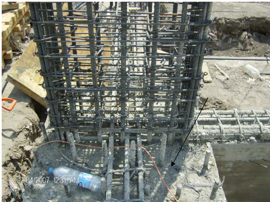
Foto 24 Se observa colado hasta el nivel de dado y trabe de liga
