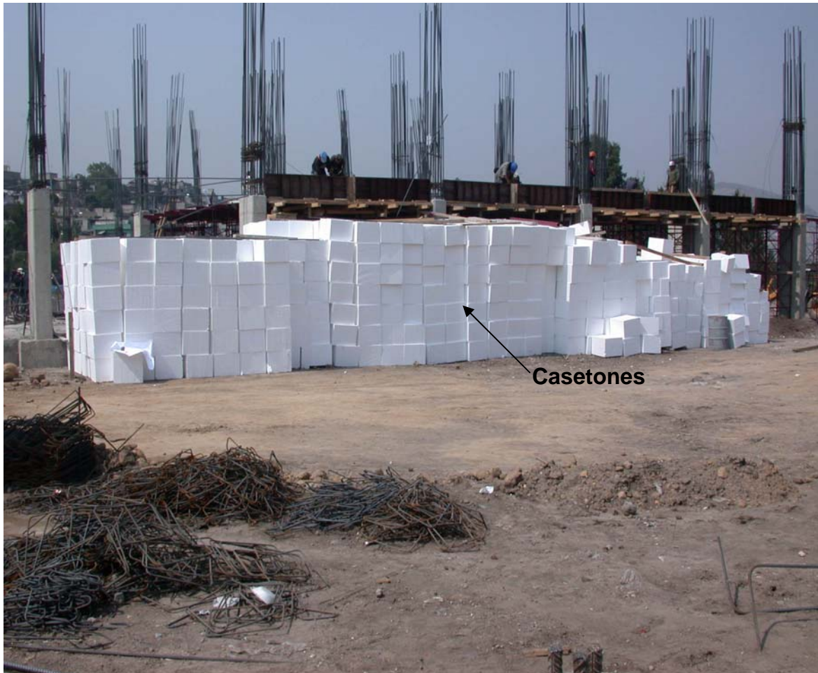
Foto 35 Almacenamiento de casetones de poliestireno
