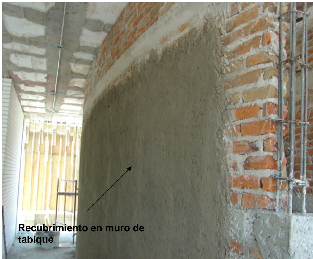
Foto 47 Recubrimiento en muro de tabique rojo
