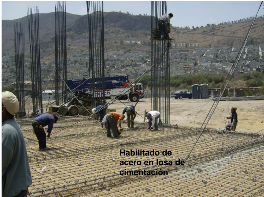
Foto 25 Habilitado de acero de refuerzo de la losa de cimentación
