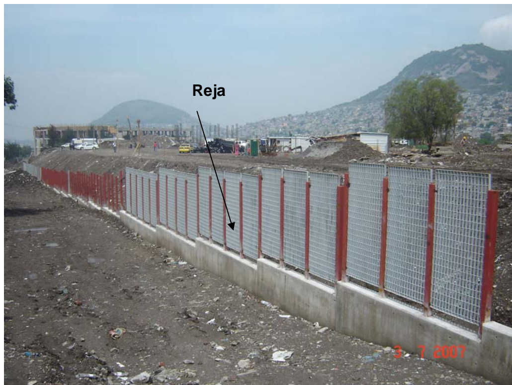
Foto 5 Colocación de reja tipo Irving
