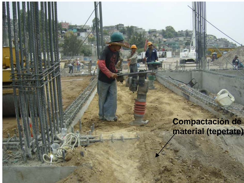
Foto 23 Compactación de material inerte (tepetate)
