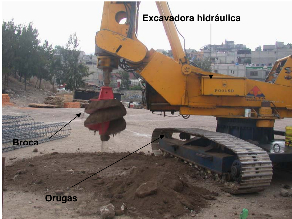
Foto 8 Inicio de los trabajos de perforación
