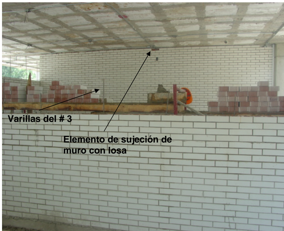
Foto 41 Aquí se muestra cambio de dirección y varillas ahogadas del # 3
