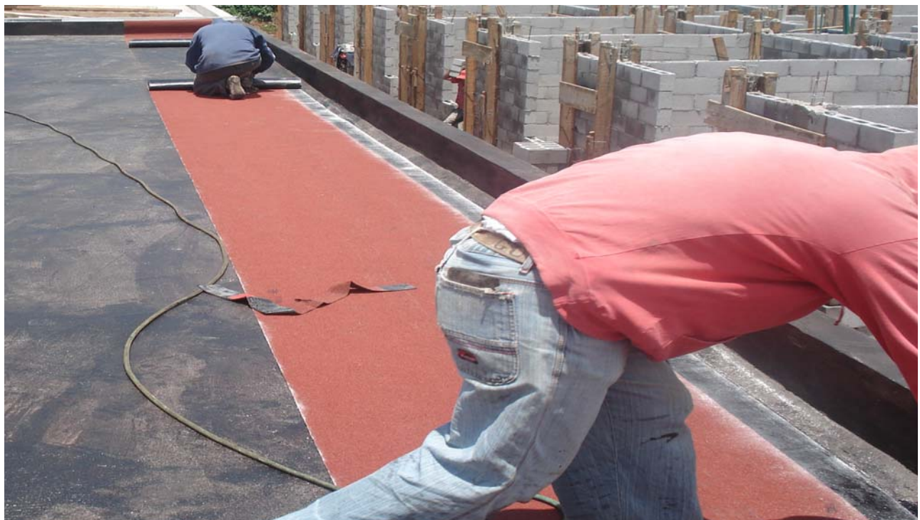
Foto 53 Tendido de impermeabilizante
