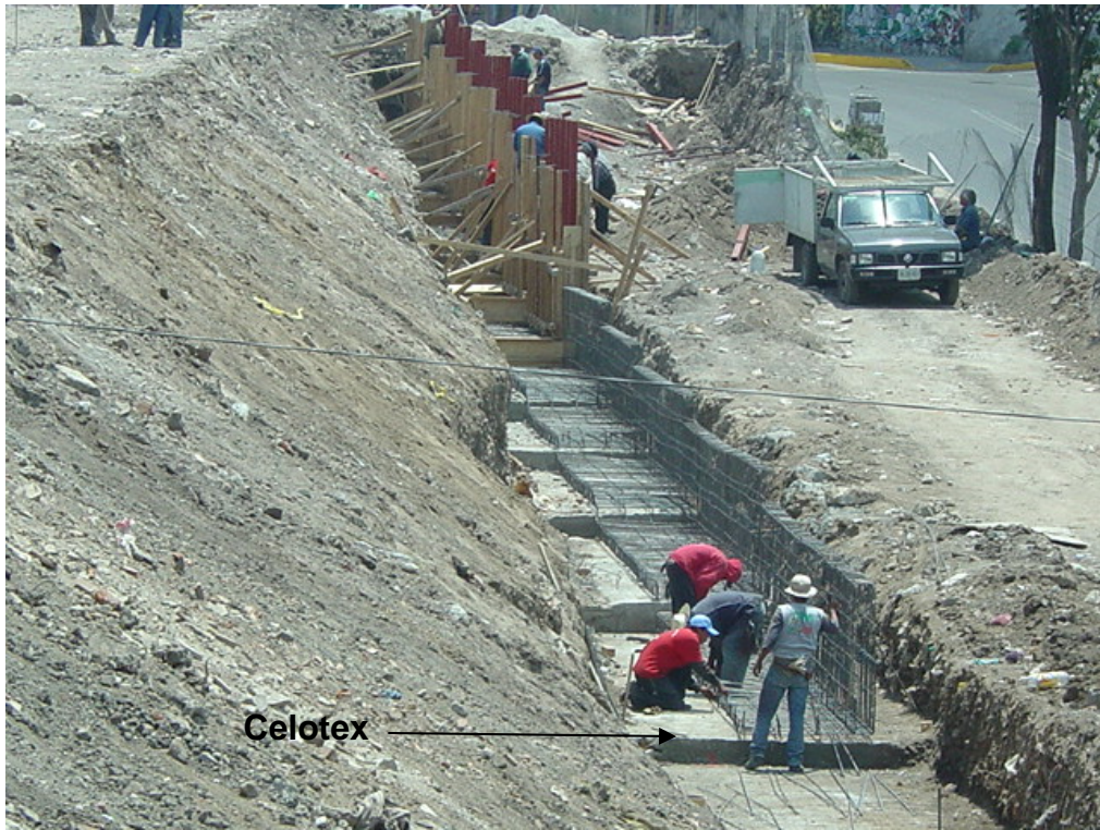
Foto 2 Colocación de celotex en junta
