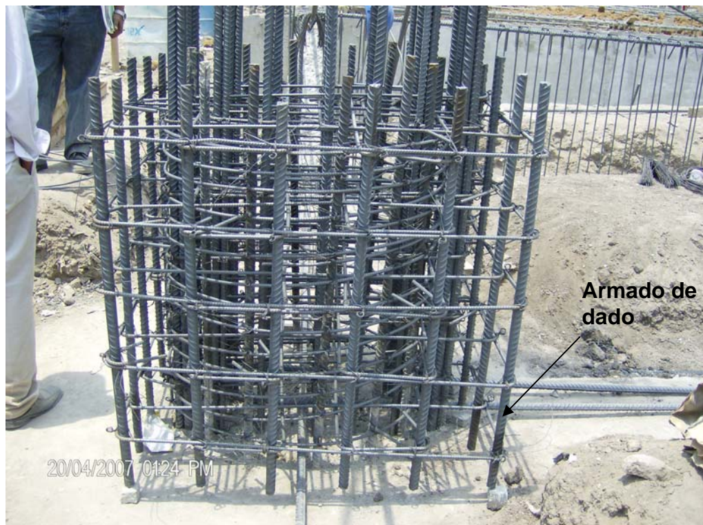
Foto 18 Armado de dado tipo
