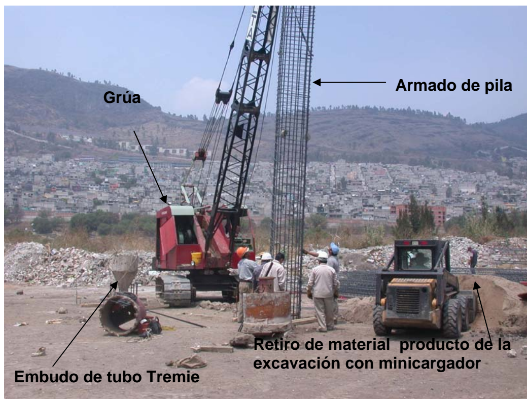
Foto 12 Colocación de armado de pila en la perforación
