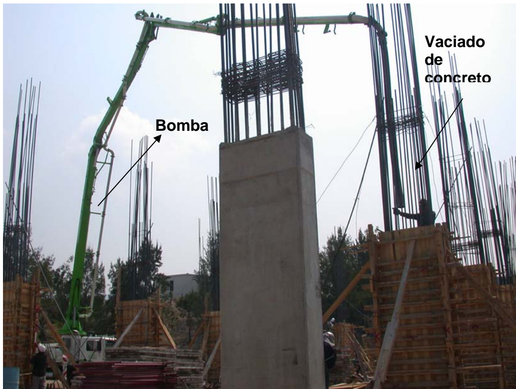
Foto 33 Colado de columnas con tubería para concreto
