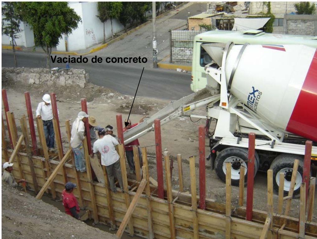
Foto 3 Colado de zapata
