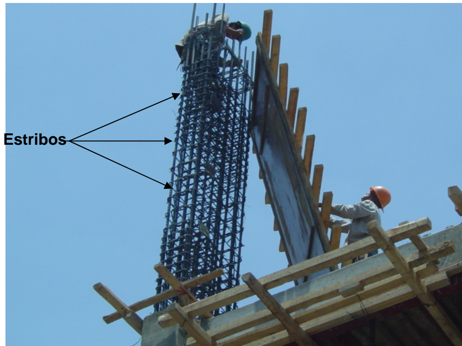
Foto 27 Colocación de estribos en columna de primer nivel de los edificios en estudio
