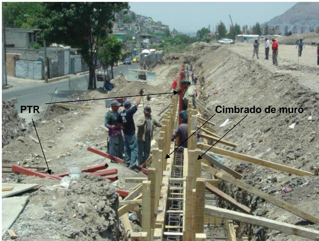
Foto 4 Colocación de PTR y cimbrado de muro
