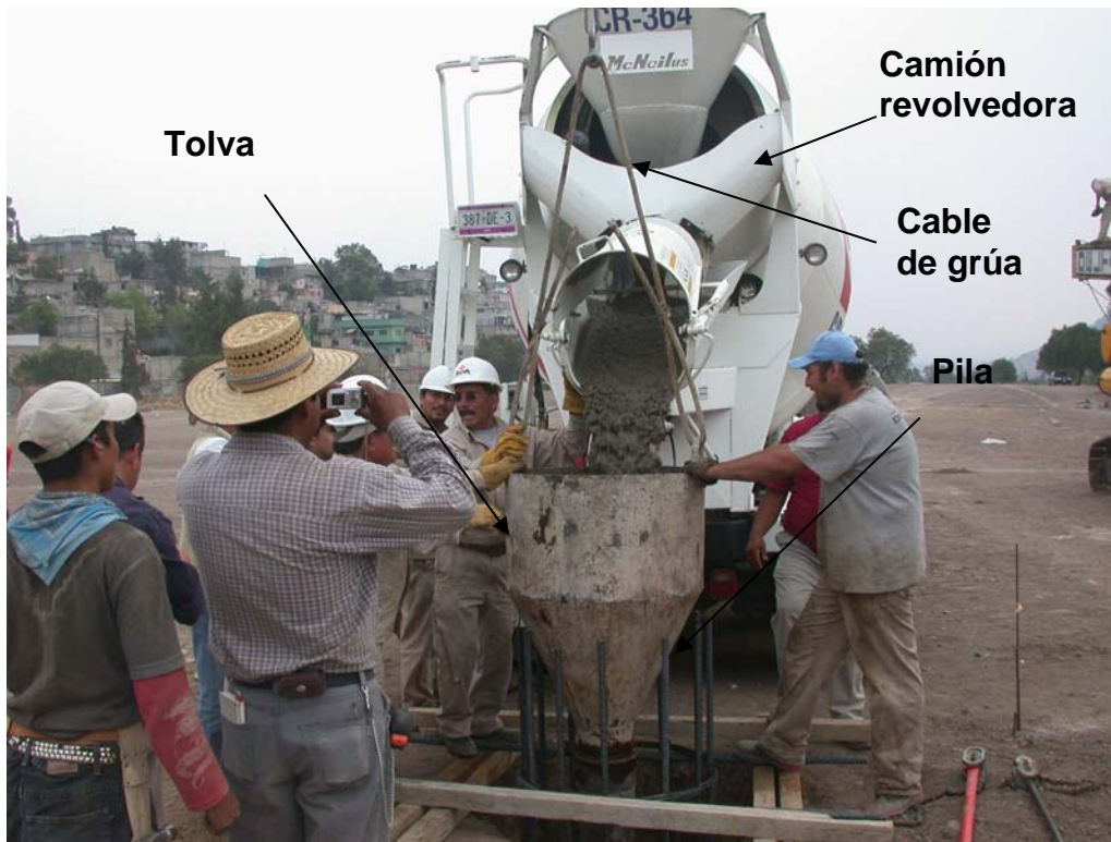
Foto 15 Se observa vaciado del camión revolvedora a la tolva
