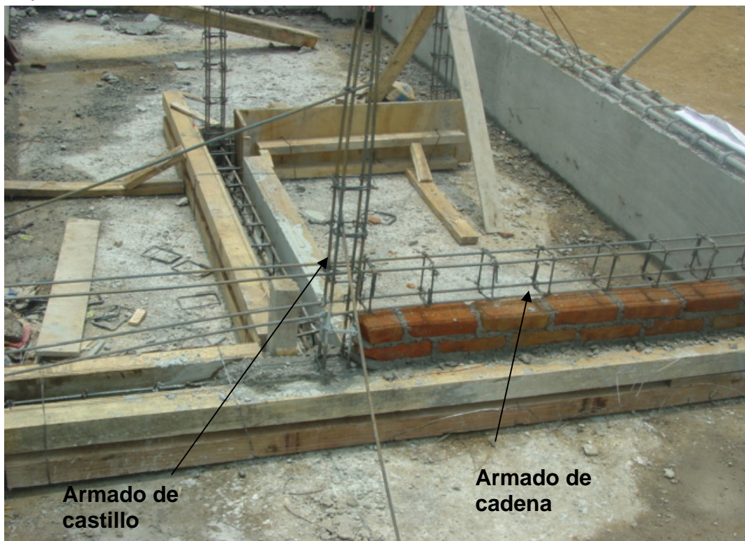
Foto 43 Apreciación de armado de cadenas y castillos
