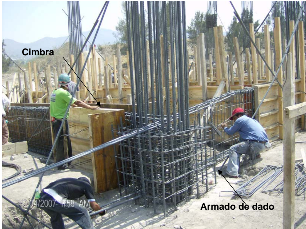
Foto 20 Armado y cimbrado de dado, trabe de liga, columna
