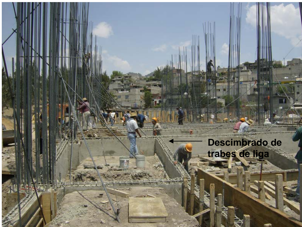
Foto 22 Descimbrado de traves de liga
