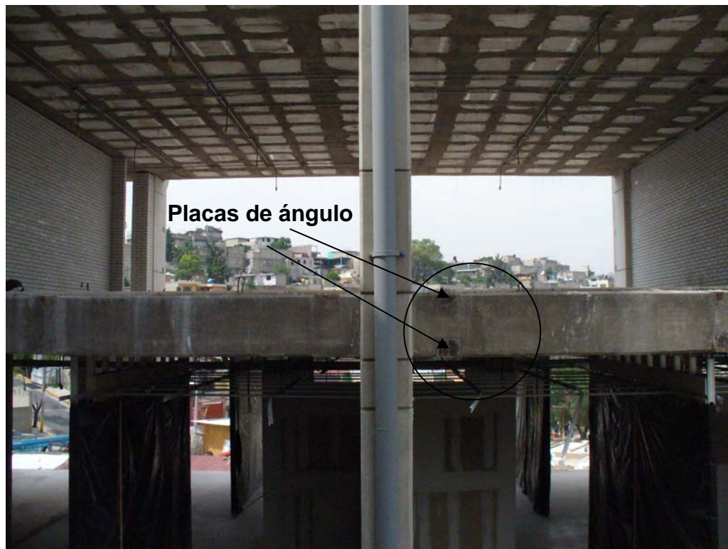
Foto 29 Colocación de placas de ángulo para prefabricados
