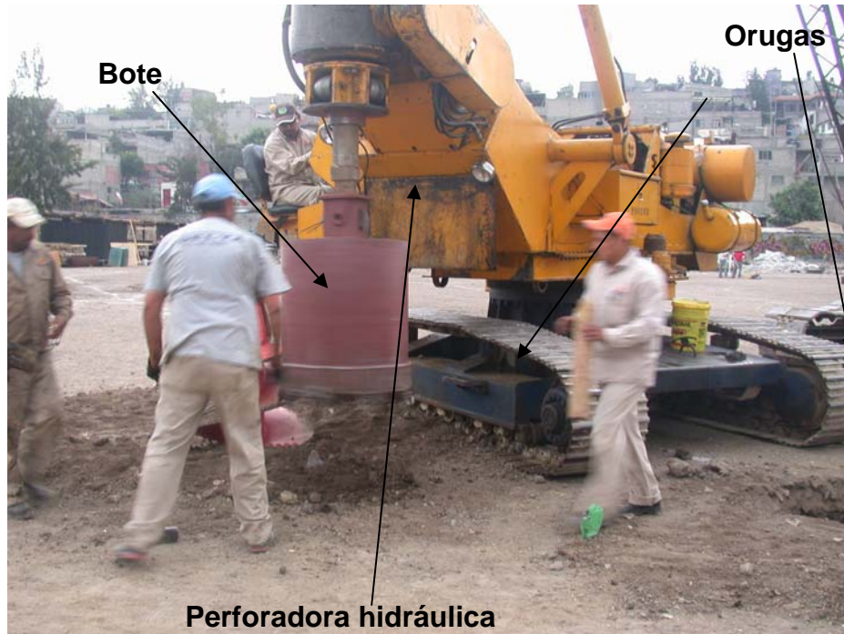
Foto 9 Trabajos de perforación con bote
