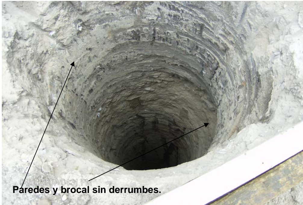
Foto 10 Condiciones físicas de la perforación terminada
