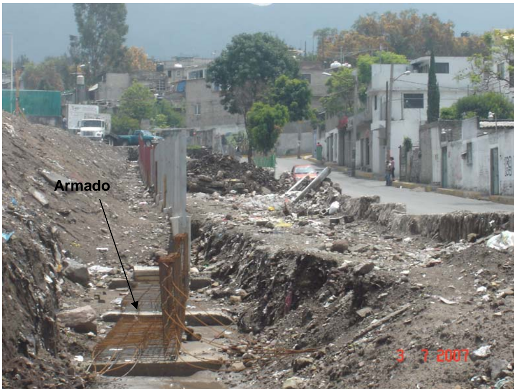
Foto 1 Armado de zapata
