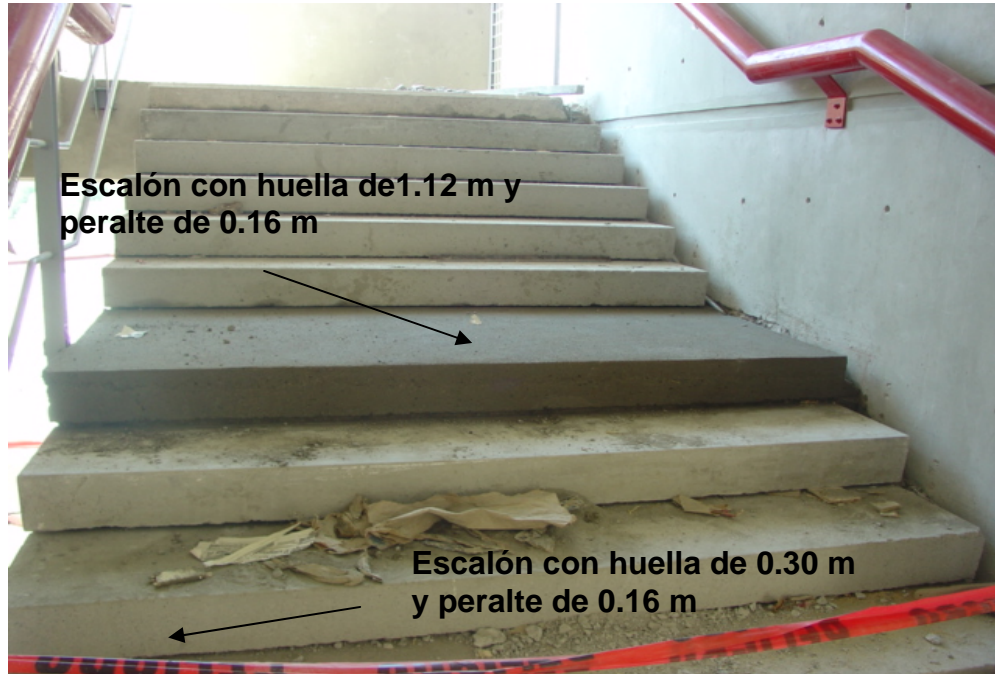
Foto 45 Forjado de escalones
