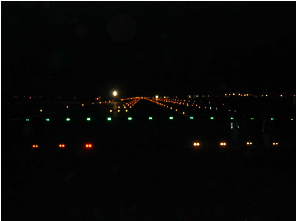
Fotografía V.40.-Luces de umbral de pista en color verde
