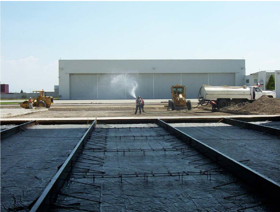
Fotografía III.5.- Disposición de barras de acero para el colado de las losas de concreto hidráulico.
