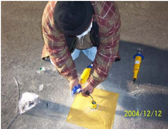
Fotografía V.48.- Instalación de unidad de borde de rodaje
