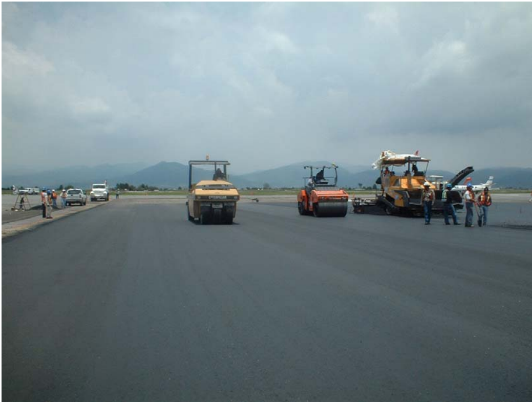
Fotografía I.10.- Compactación de carpeta asfáltica empleando compactador de rodillo liso vibratorio-oscilatorio en tandem ( del lado derecho) y compactador sobre neumáticos (del lado izquierdo).
