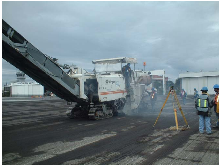
Fotografía I.1.- Fresado de carpeta asfáltica con perfiladora de pavimentos.
