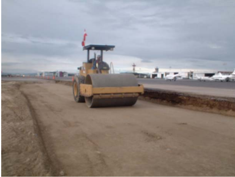
Fotografía II.7.- Compactación de material de préstamo de banco con compactador mixto
