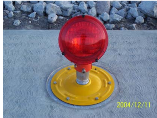
Fotografía V.9.- Unidad de aproximación de luz color rojo.
