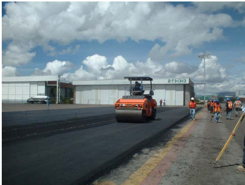
Fotografía III.2.- Compactación de carpeta asfáltica en plataforma.
