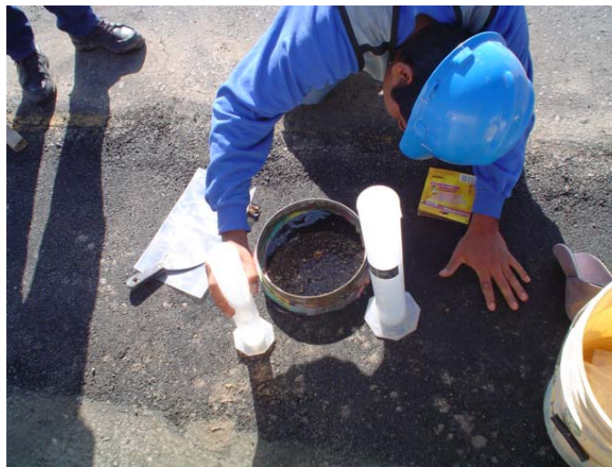
Fotografía I.12.- Prueba para determinar la permeabilidad de la carpeta asfáltica.
