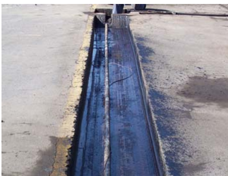
Se instala la tubería para el cableado y se impregna
