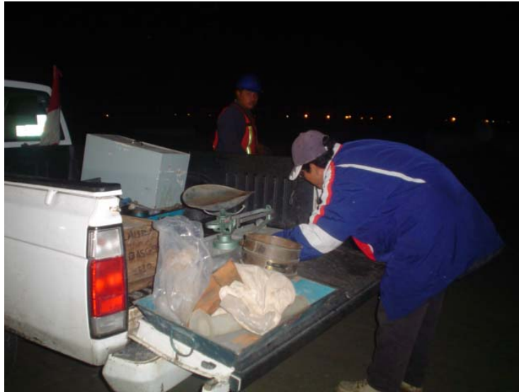
Fotografía I.13.- Laboratorio en campo realizando pruebas que determinen la compactación de las capas del pavimento.
