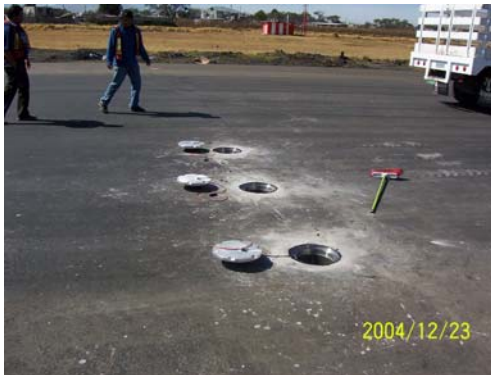
Se sellan los bordes con grout, se realiza la instalación eléctrica y se realizan las pruebas para comprobar su funcionamiento.
