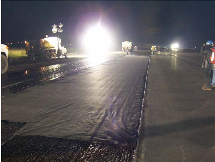
Fotografía I.5.- Malla geotextil en proceso de colocación sobre superficie ligada.
