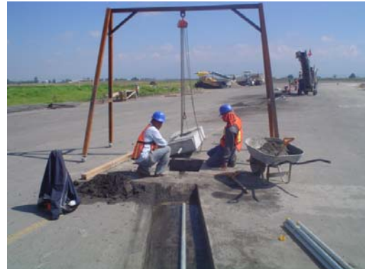
Colocación del cemento registro empelado el portal con polipasto.
