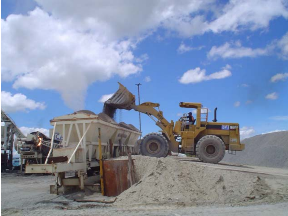
Fotografía I.7.- Dosificación de los agregados pétreos a las tolvas de la planta de asfalto.
