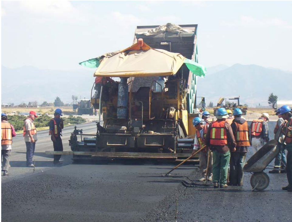
Fotografía I.14.- Colocación de mezcla asfáltica en acotamientos.
