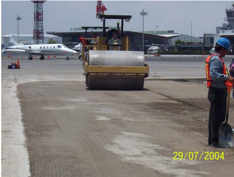
Fotografía II.5.- Compactación de base en rodajes.
