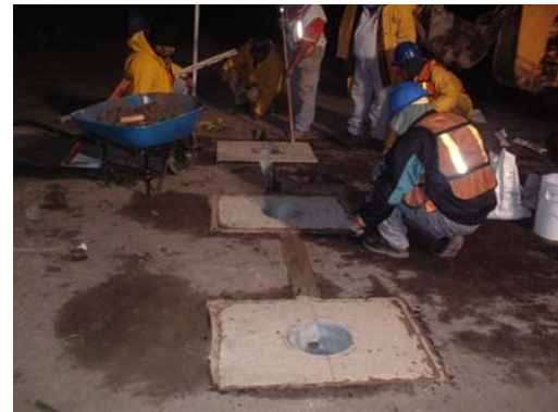
Se rellenan los bordes del cemento registro con grout para ajustar.
