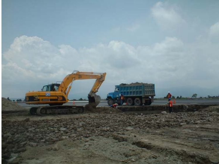
Fotografía II.3.- Excavación con retroexcavadora y carga a camiones
