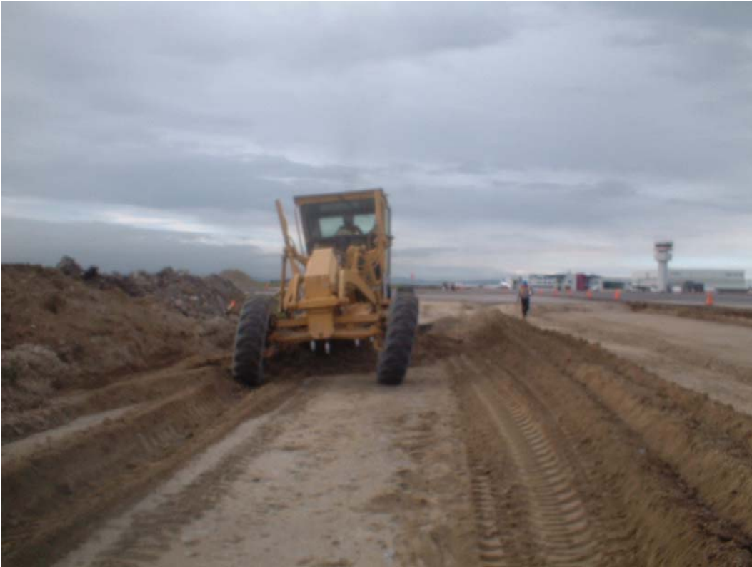
Fotografía I.15.- Motoconformadora en labores para la construcción de las franjas de seguridad de la pista.
