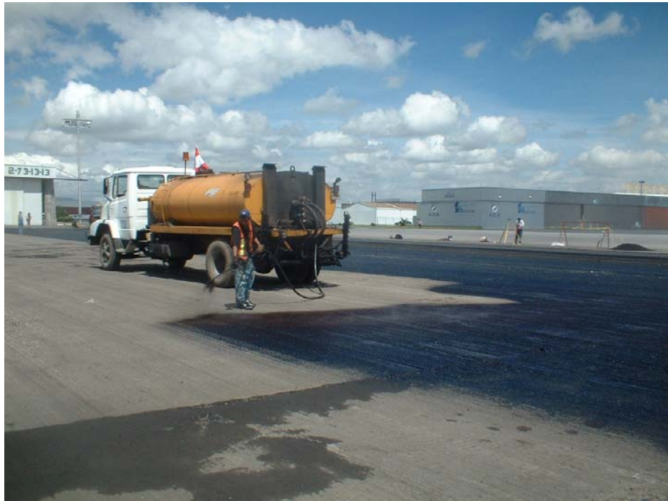
Fotografía I.3.-Riego de liga con petrolizadora empleando bacheador.
