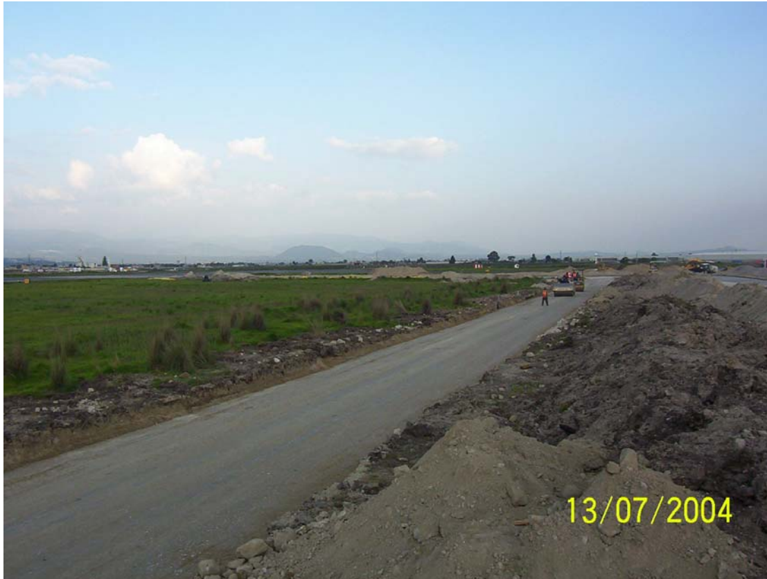
Fotografía IV.2.- Capa subrasante del camino de servicios.
