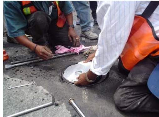
Y se ajusta empleando la unidad rasante para que quede al nivel de la carpeta asfáltica.
