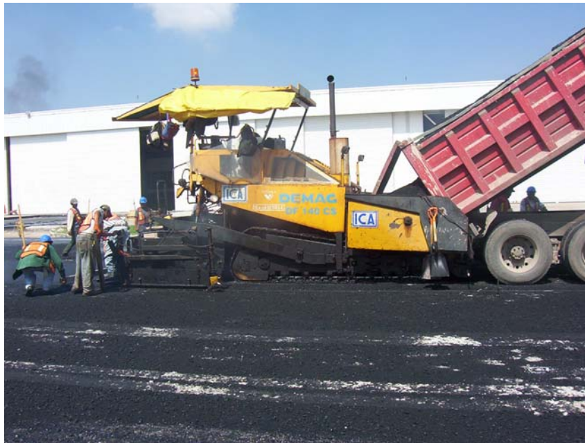
Fotografía I.8.- Colocación de mezcla asfáltica con pavimentador
