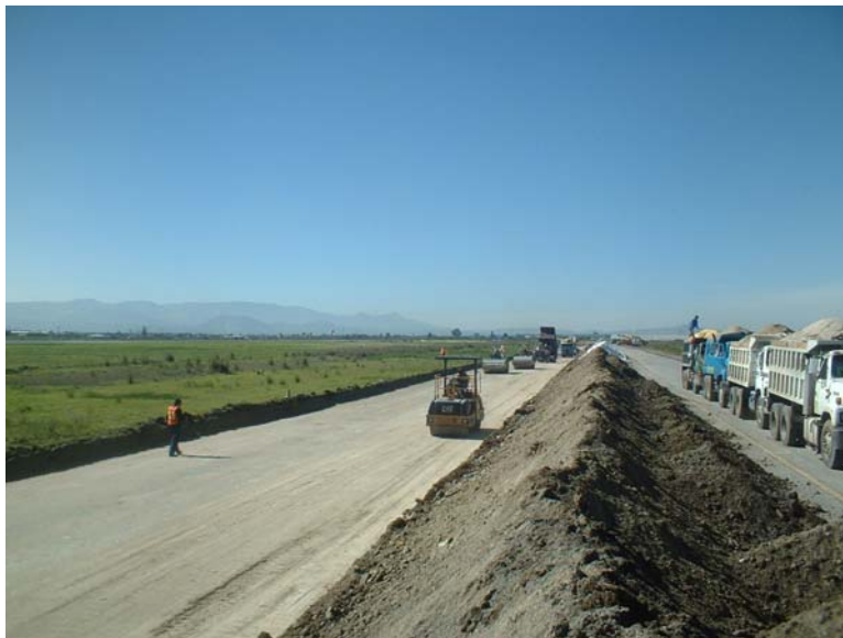
Fotografía IV.3.- Compactación de base en camino de servicios.
