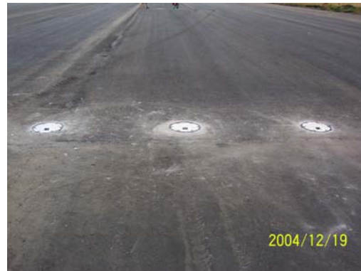
Finalmente se ajusta la unidad de señalamiento rasante fijándola con los tornillos.
