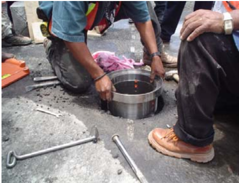
Se coloca la extensión ó arillo adaptador.
