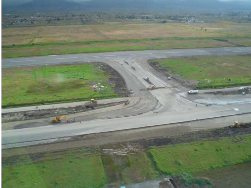
Fotografía II.6.- Construcción de filete y ampliación de rodaje.
