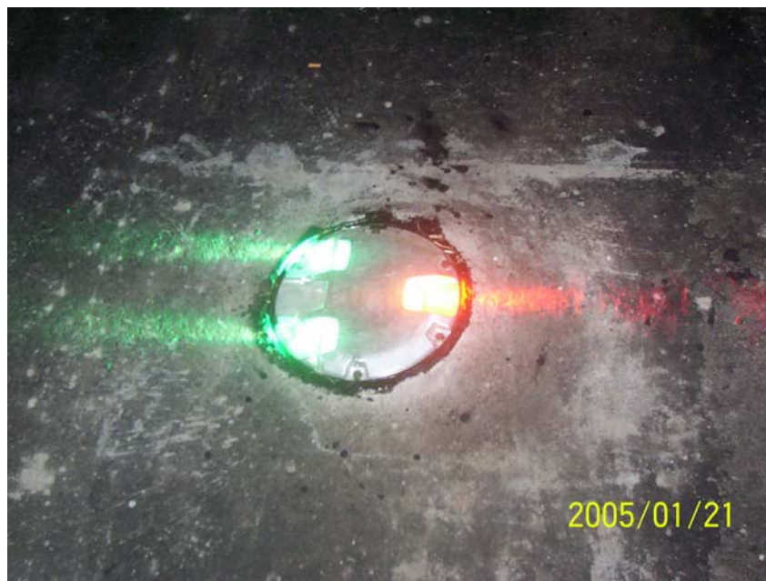
Fotografía V.38.- Unidad rasante para umbral (luces color verde) y extremo de pista (luz color roja)
