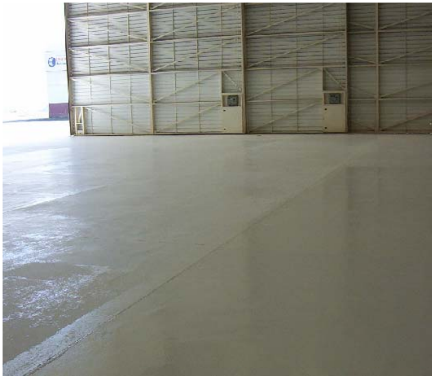
Fotografía III.6.- Acabado pulido en losa de hangar.
