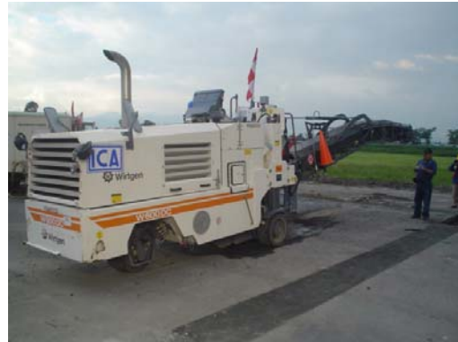
Perfiladora Wirtgen W600.
