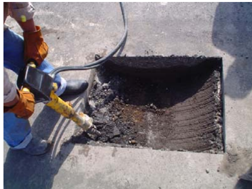
Demolición y remoción del pavimento sobrante.
