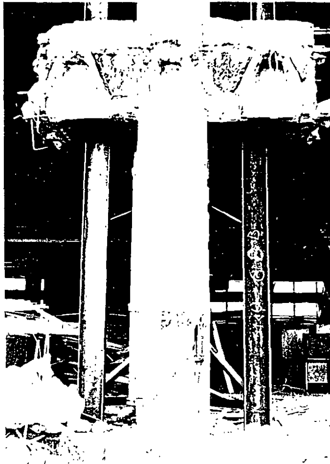
Fig 11 Daño en columnas
