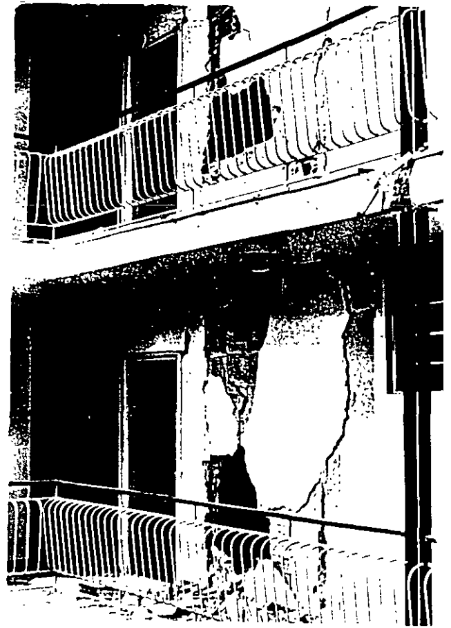
Fig 2 Daños en fachadas "no estructurales"
