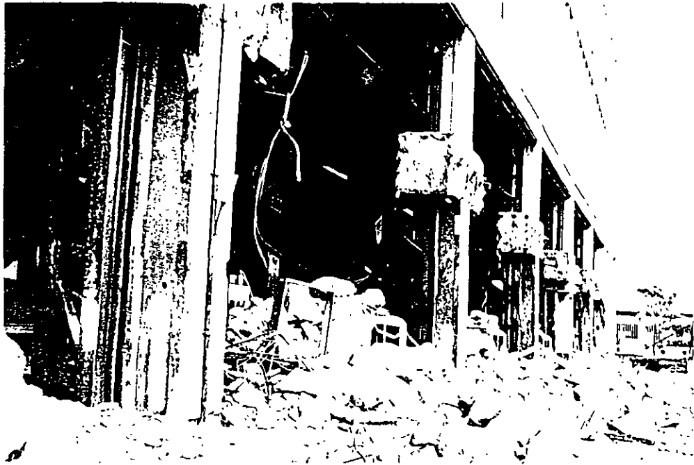
Fig 15 Demolición de marquesina
