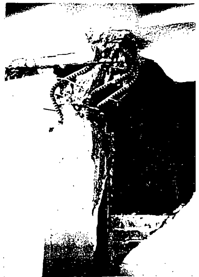
Fig 3 Daños a muros no estructurales así como a elementos estructurales ( Nótese el ancho de la diagonal "equivalente" )
