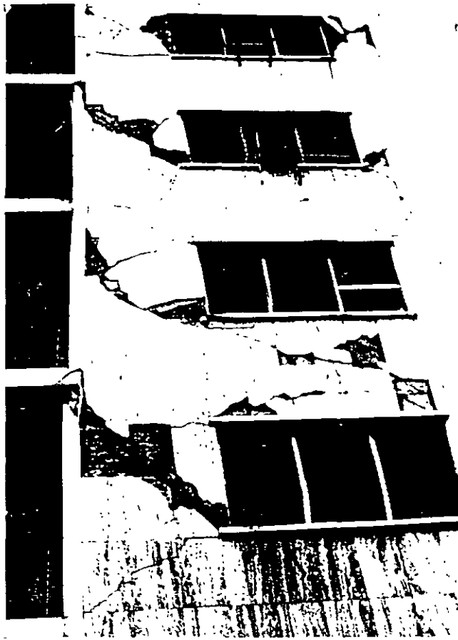
Fig 2 Daños en fachadas "no estructurales"
