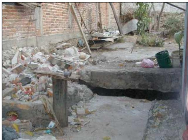
Figura 2.15. Hundimiento de piso en Villa de Álvarez, Colima. (*Bitrán, et al., 2003*)
