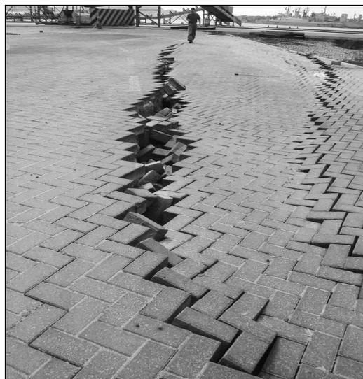
Figura 2.16. Desplazamiento lateral en el puerto de Manzanillo.
