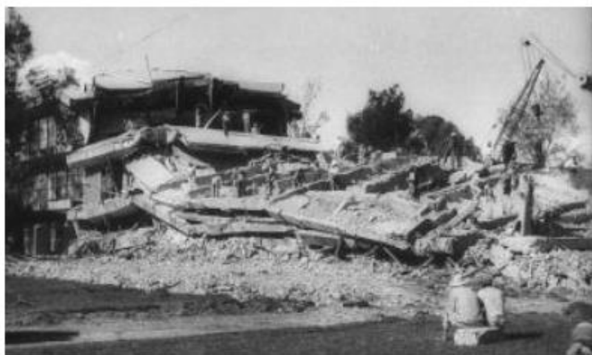
Figura 1.11. Colapso del ala sur del edificio del IPN a causa del sismo de 1957 (Reinoso y Orozco, 2007).
