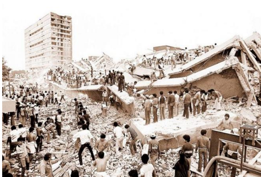
Figura 1.4. Escombros del Centro Médico Nacional después del terremoto de 1985.
