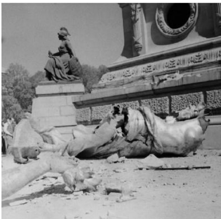
Figura 1.10. Colapso del Ángel de la Independencia, debido al sismo de 1957 (Montero, 2012).
