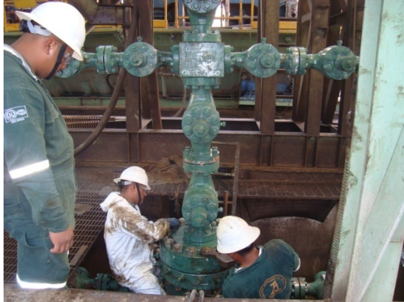
FIGURA 3-12. Instalando Medio Árbol de Válvulas.
