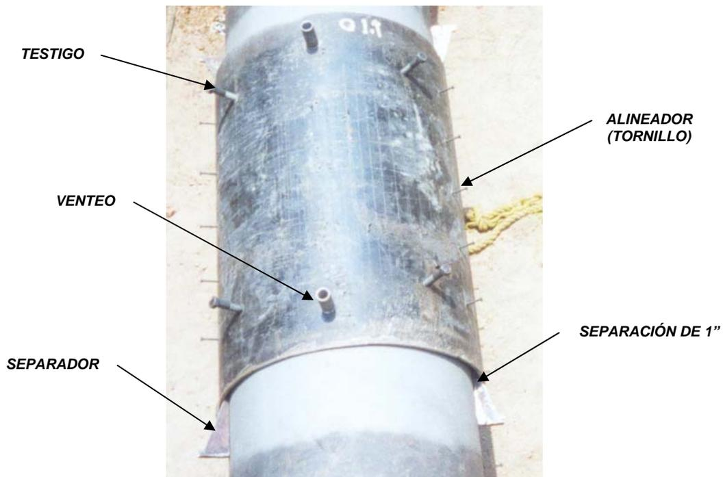
Una vez alineada simétricamente la envolvente alrededor del tubo, se procede a colocar una pasta en los extremos de dicha envolvente que sustituirá a la soldadura circunferencial, que resulta de alto riesgo en la envolvente metal a metal. Esta pasta tarda aproximadamente 30 mins. en alcanzar su máxima resistencia.
