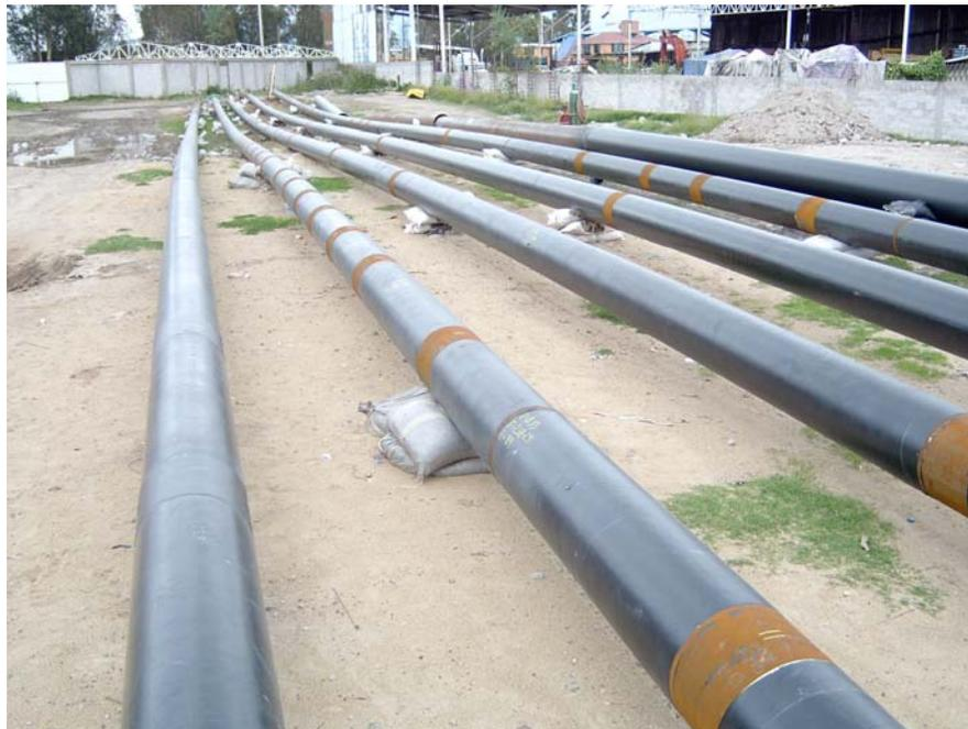
**JUNTAS SOLDADAS SIN PROTECCIÓN MECÁNICA DURANTE LA PRUEBA HIDROSTÁTICA**
