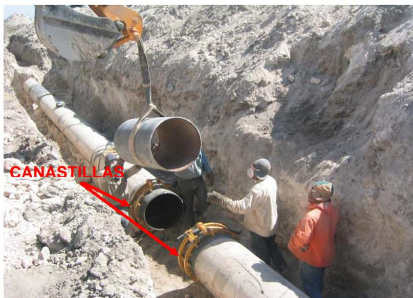
**ALINEACIÓN CON CANASTILLA PARA EL PUNTEO DEL TUBO**
