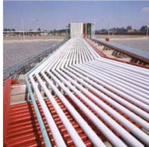
Un ducto es una tubería de acero al carbón que va de las 2" a las 48" de diámetro y que transporta los diferentes productos derivados del petróleo; de ahí que adquieran el nombre del producto que transporta.
