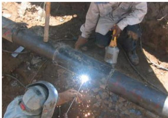
**SOLDADURA LONGITUDINAL DE ALTO RIESGO EN ENVOLVENTE METAL A METAL**
