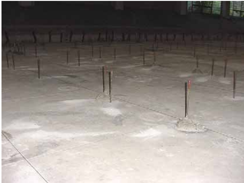
Fig. 2.3 Identificación de varillas de acuerdo al nivel batimétrico
