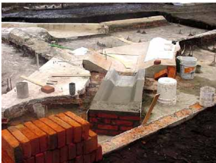
Fig. 4.4 Construcción del canal de margen derecha
