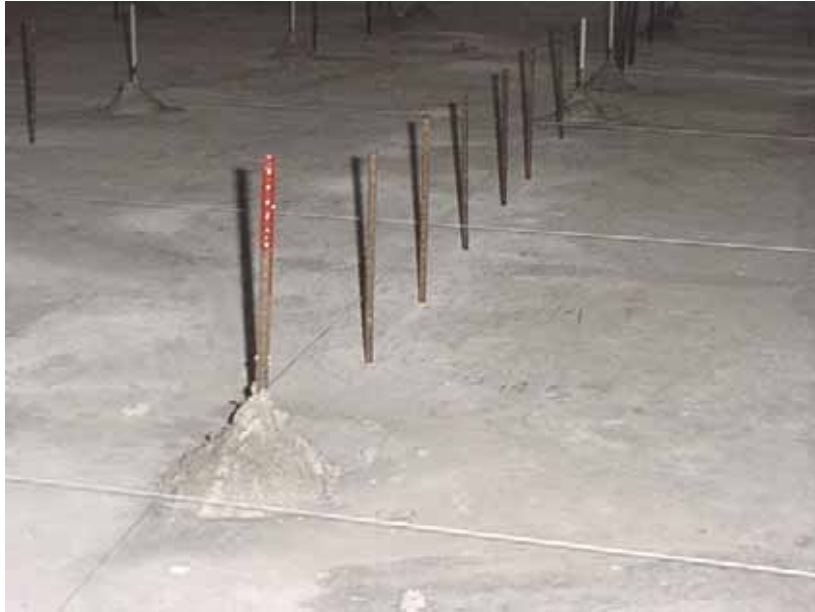
Fig. 2.4 Nivelación de las varillas para configurar la batimetría
