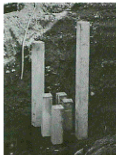
Pilotes prefabricados colocados
