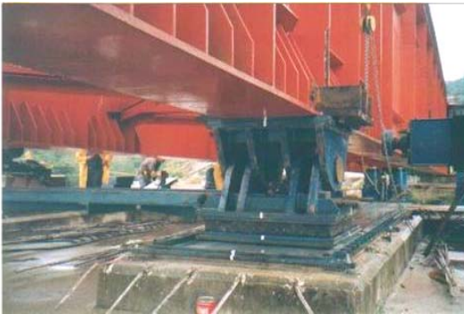
Apoyo móvil deslizante, utilizado en los cabezales de pilas.
