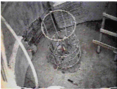
Cabezal de un pilote colado in – situ
