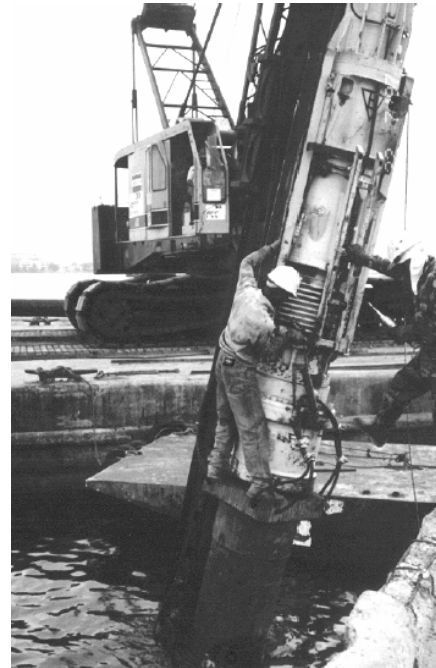
Fig. 5. Hincado de pilote con martillo diesel.
