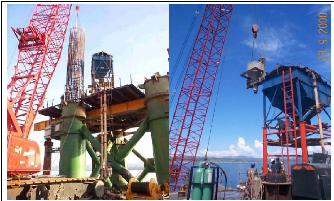
Figura 2.13 Colocado del armado y colado para los pilotes
