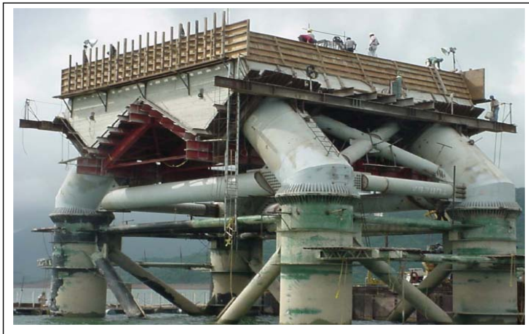
Figura 2.15 Cimbra y colado de los cabezales
