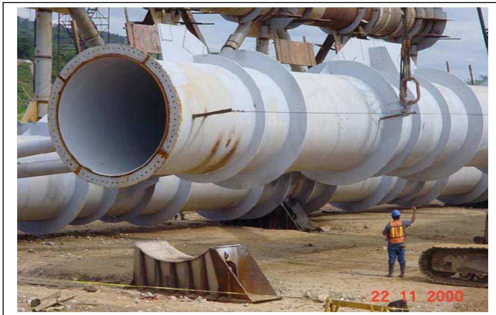
Figura 2.5 Tubo principal montado sobre cuna de acero
