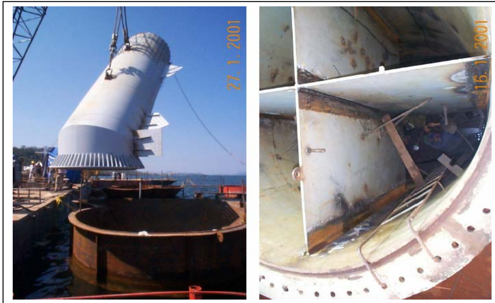
Figura 2.14 Montaje de módulos superiores
