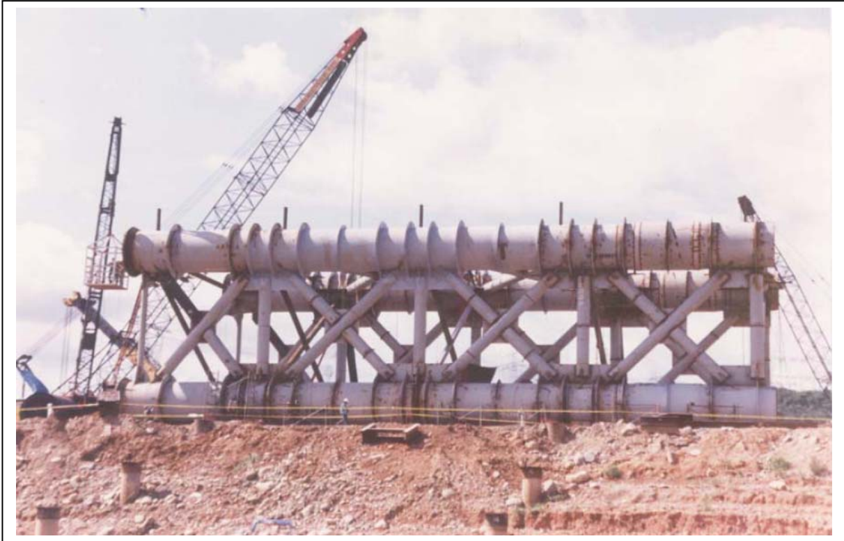
Figura 2.6 Posición durante el ensamblado de la pila
