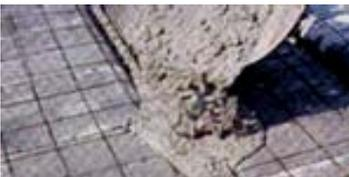
Se tapan los huecos de las bovedillas extremas, se mojan perfectamente las viguetas y bovedillas y se procede al colado de la capa de compresión.
