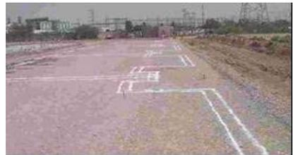
Figura 2.7 Trazo perimetral sobre la plataforma
