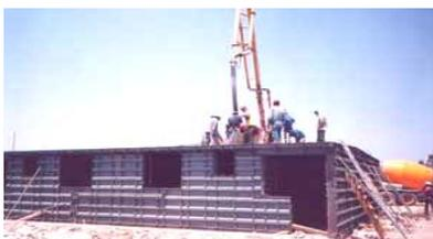
**Figura 3.9 Colado de muros y losa**
