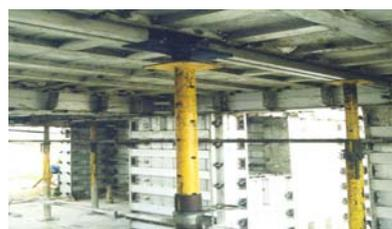
**Figura 3.7 Colocación de cimbra en losa**
