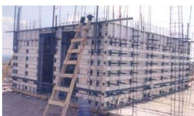
**Figura 3.6 Colocación de cimbra en muros**
