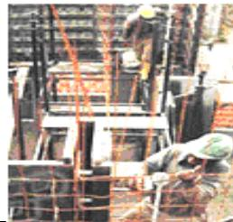
C-4. La unión entre paneles se realiza con pasadores (fijos o sueltos) y cuñas; en la medida en que se ensamblan las dos caras de cada muro. Ver figura adjunta.
