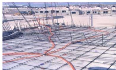
**Figura 3.8 Colocación de acero e instalaciones**
