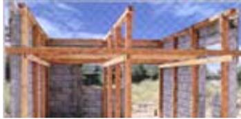
Se colocan puntales (4" x 4") y largueros de apoyo y nivelación (4" x 4"). Retirar a los 7 días del colado de la capa de compresión.
