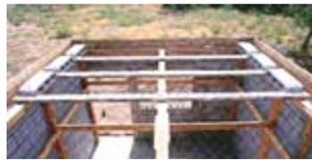
Se colocan las bovedillas de los extremos para dar la separación correcta entre viguetas.
