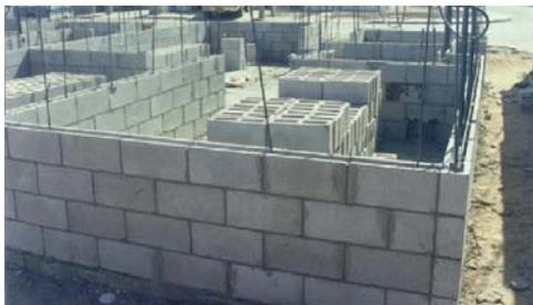
**Figura 3.1 Junteo adecuado. Separación adecuada en todas las juntas y mortero colocado uniformemente**
