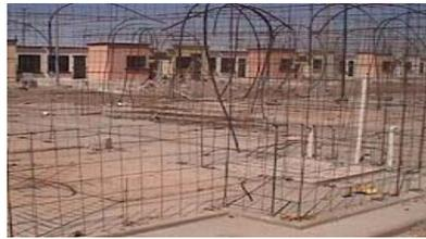
**Figura 3.5 Colocación de acero e instalaciones**
