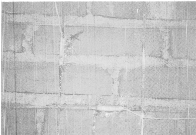
Figura 30. Malla metálica anclada a un muro de mampostería con clavos.
