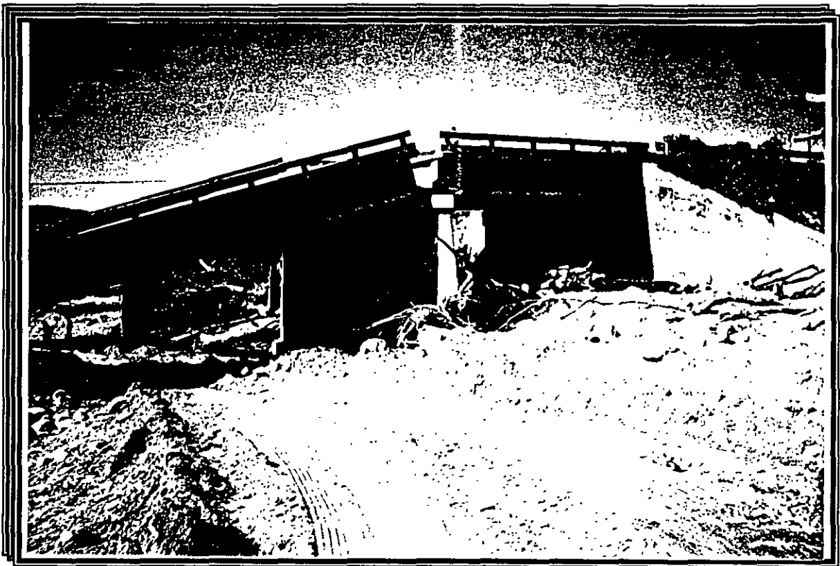
FOTO No. 5 Panorama general del puente fallado, Puente "Pedregal".
