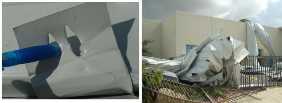
*Figura 2.2. Falla local en los sujetadores de la lámina. (Murià, et al., 2016)*
