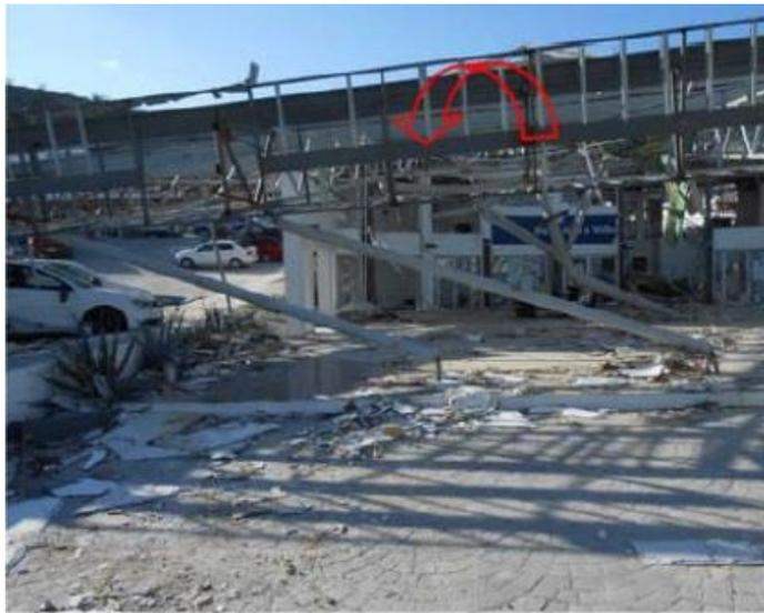
*Figura 1.1. Colapso de Nave Comercial por el huracán Odile en Baja California (Murià, et al., 2016).*
