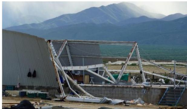
*Figura 2.1. Colapso parcial de nave industrial a causa del Huracán Odile. (Murià, et al., 2016)*
