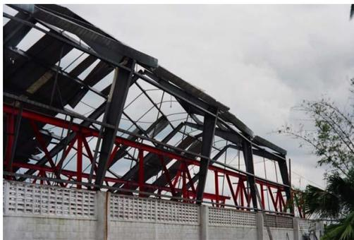
*Figura 2.15. Falla en el anclaje a causa de la corrosión en los tornillos (López Bátiz & Toledo Sánchez, 2003)*
