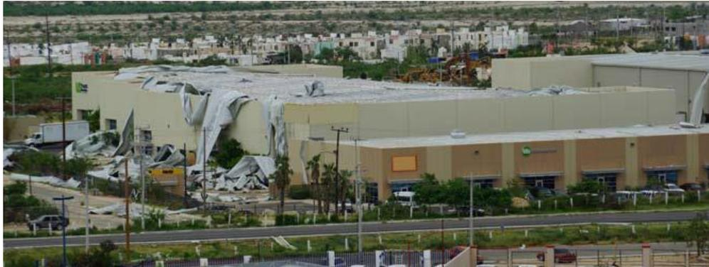
**Figura 2.6. Daños en cubiertas de nave comercial. (Murià, et al., 2016)**
