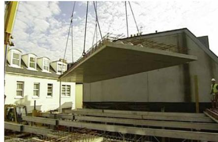
**Fig. 3.3 Elevación del panel**
