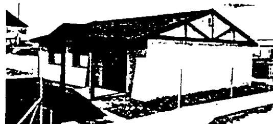
Techos y muros en casa de San Juan del Rio, Queretaro.
