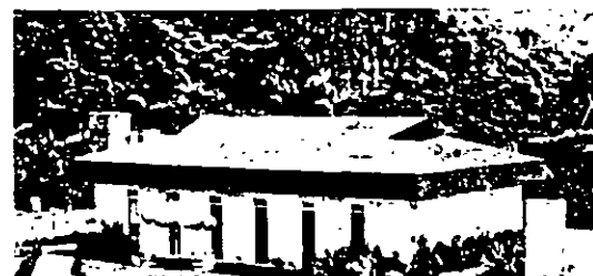
Techos y muros en caseta de ventas Lomas Anahuac, Edo. de Mexico.
