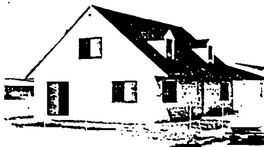
Casa terminada en San Juan del Rio, Queretaro
