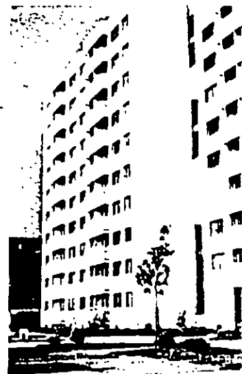
Cimbra integral de PAMACON en muros y entrepisos (Alemania).
