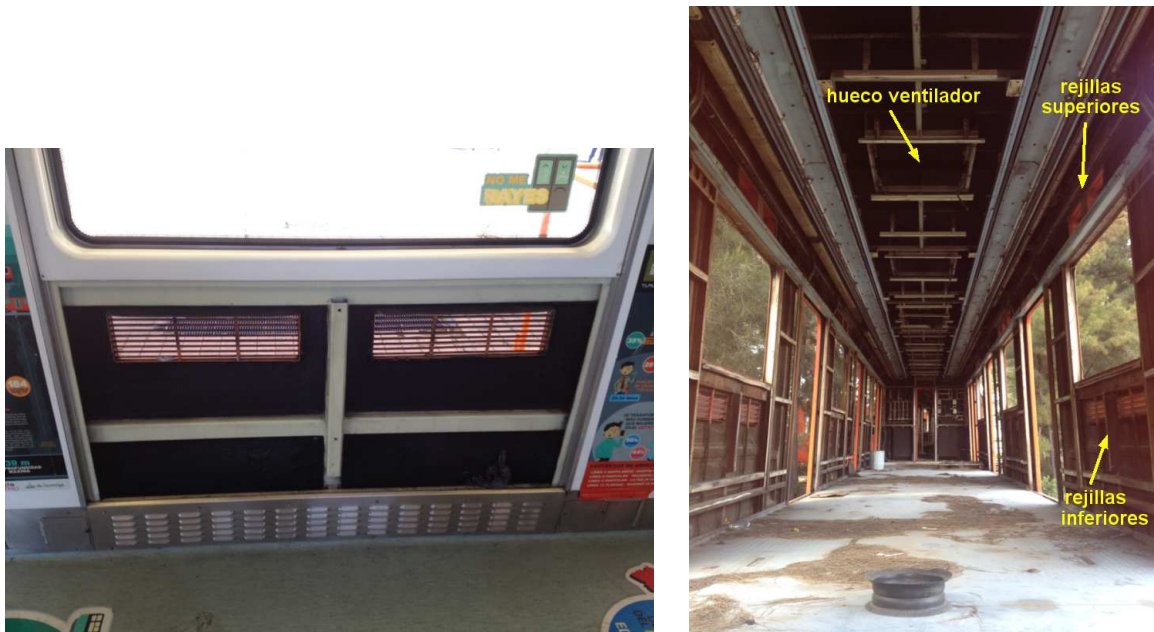
Figura 1.7: Izquierda: estructura interna de las rejillas de ventilación, debajo de la ventana y vistas por dentro, de un vagón de la exposición “Motriz didáctica”. Derecha: estructura interna de un vagón NM-83 desmantelado en desuso en talleres de mantenimiento de Zaragoza. Elaboración propia.
