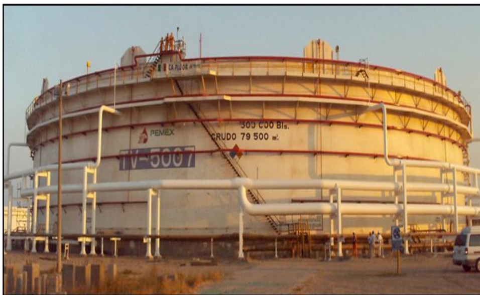
Fig.4.4.-Tanque de almacenamiento convertido a “Gun Barrel”.
