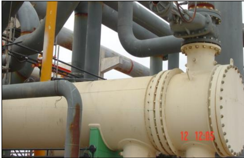
Fig. 5.6.-Calentador de Crudo.
