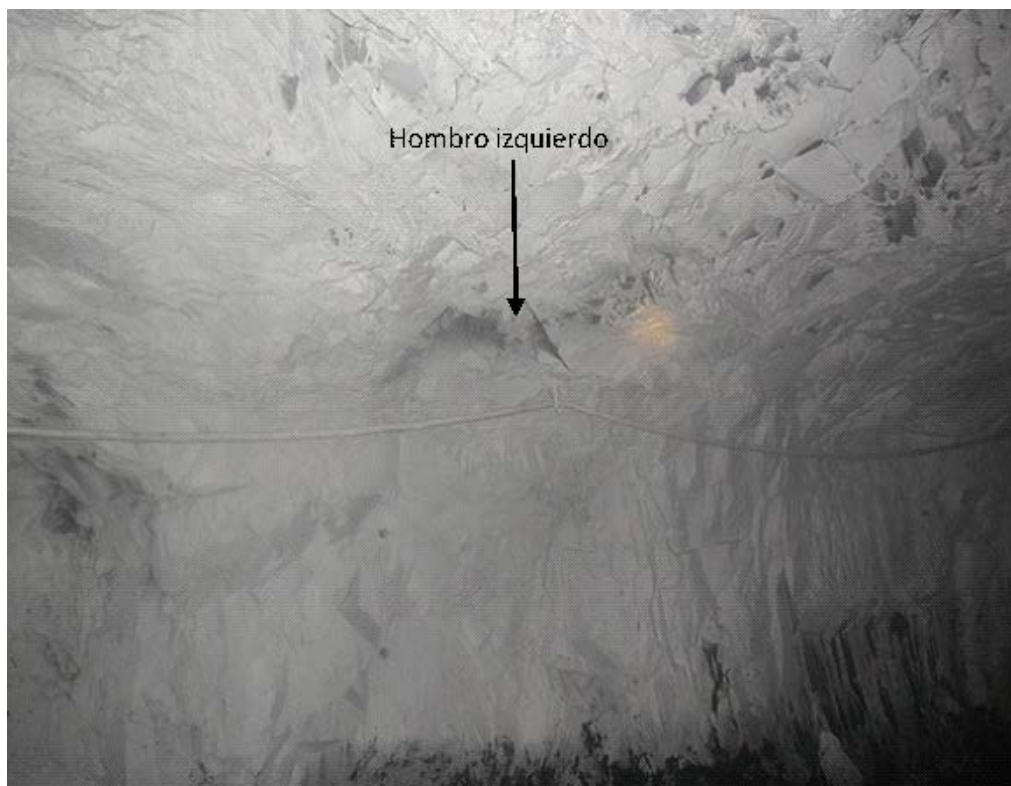
Figura 42: Acceso sin soporte alguno. (Fotografía tomada en 2013)
