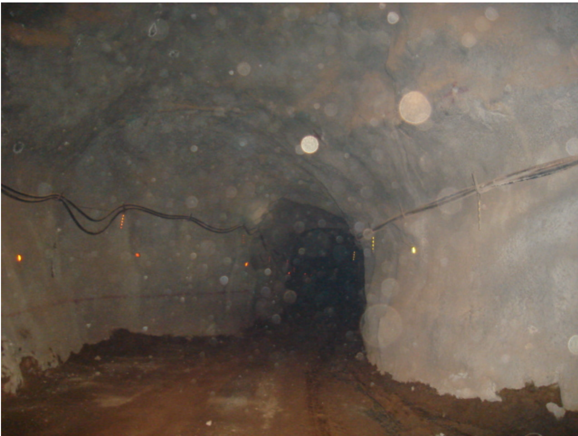
Figura 54: Líneas de servicio colocadas correctamente. (Fotografía tomada en 2012)
