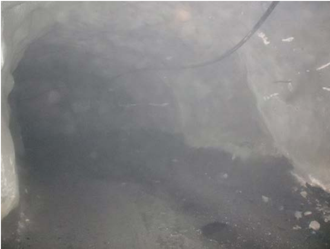
Figura 41: Problemática corregida de la obra. (Fotografía tomada en 2014)
