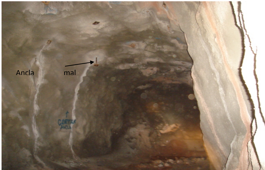
Figura 49: Rampa soportada para seguir con el avance. (Fotografía tomada en 2013)
