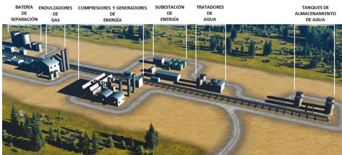
Figura 5.6 Instalación central de procesamiento, (Petrobank Energy and Resources Ltd., 2006).
