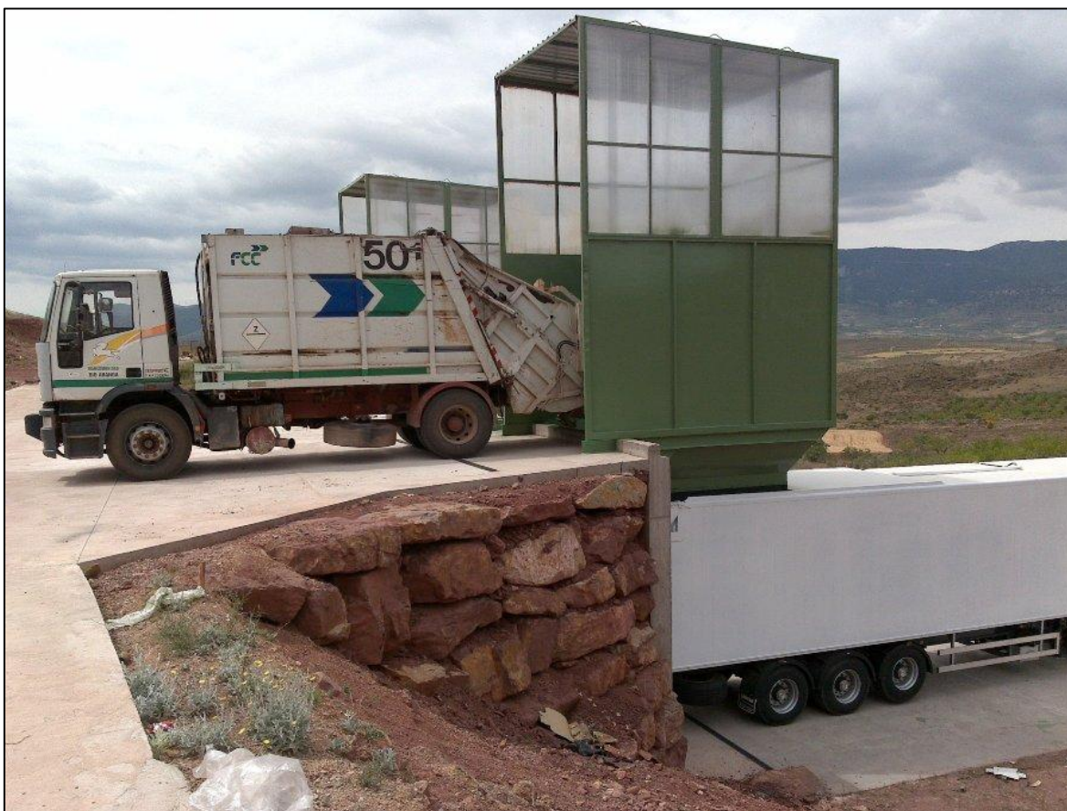
Figura 8 Estación de transferencia, COGERSA
