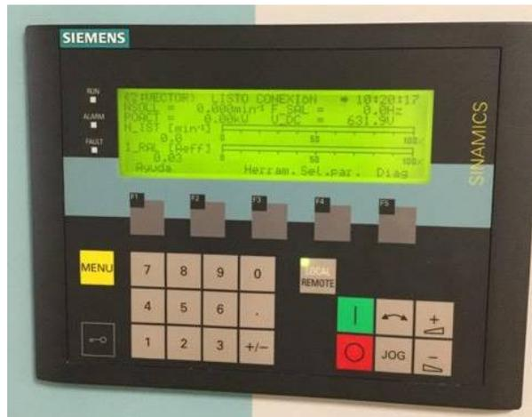
Figura 14. Fotografía del panel de control del ventilador
