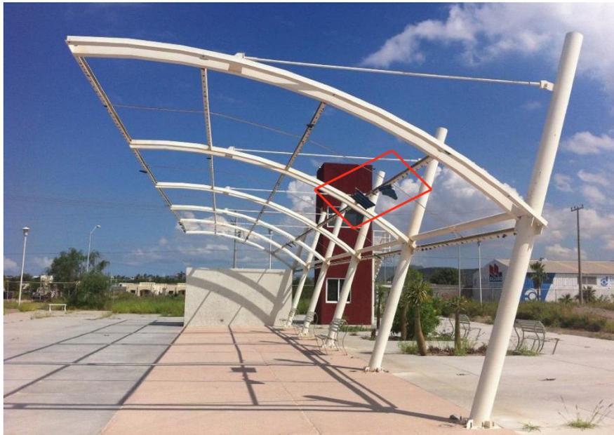
Figura 30. Desprendimiento de cubierta en estructura tipo arco (iingen UNAM, 2015)
