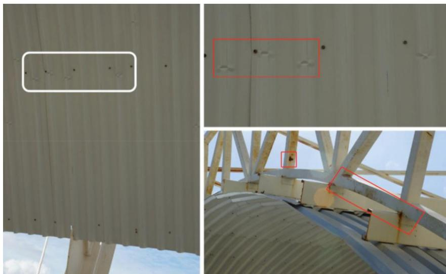
Figura 29. Deformaciones en cubierta y oxido por intemperismo (iingen UNAM, 2015)
