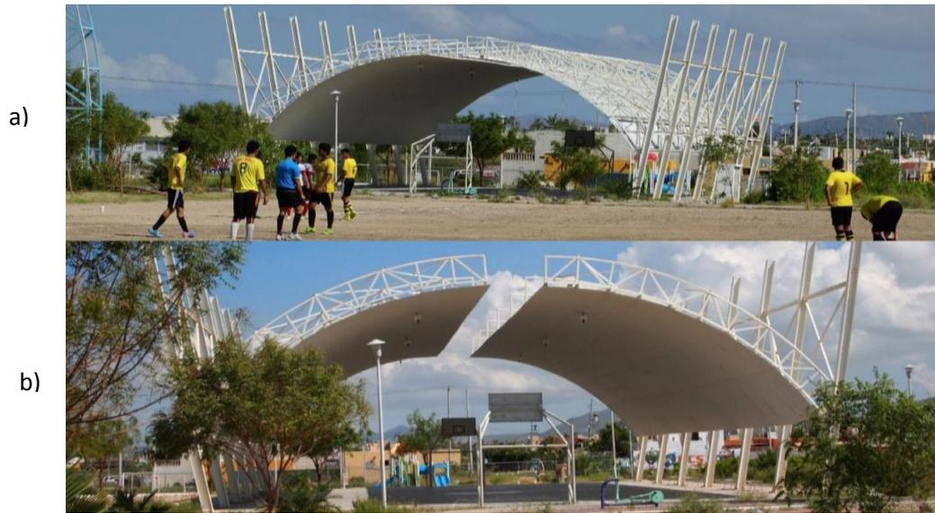
Figura 28. Estructura arco - columna a) diseño original y b) estructura dañada por vientos del huracán Odile (iingen UNAM, 2015)
